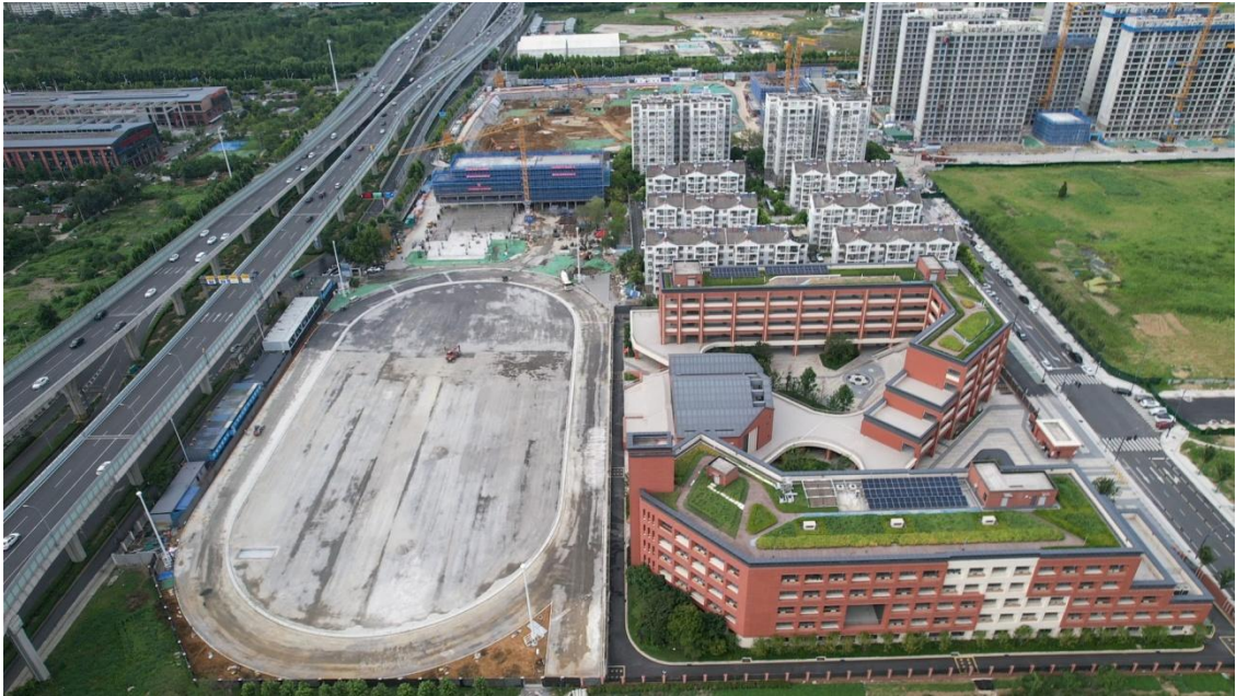
教学楼、报告厅、综合楼已完工区域现状航拍
