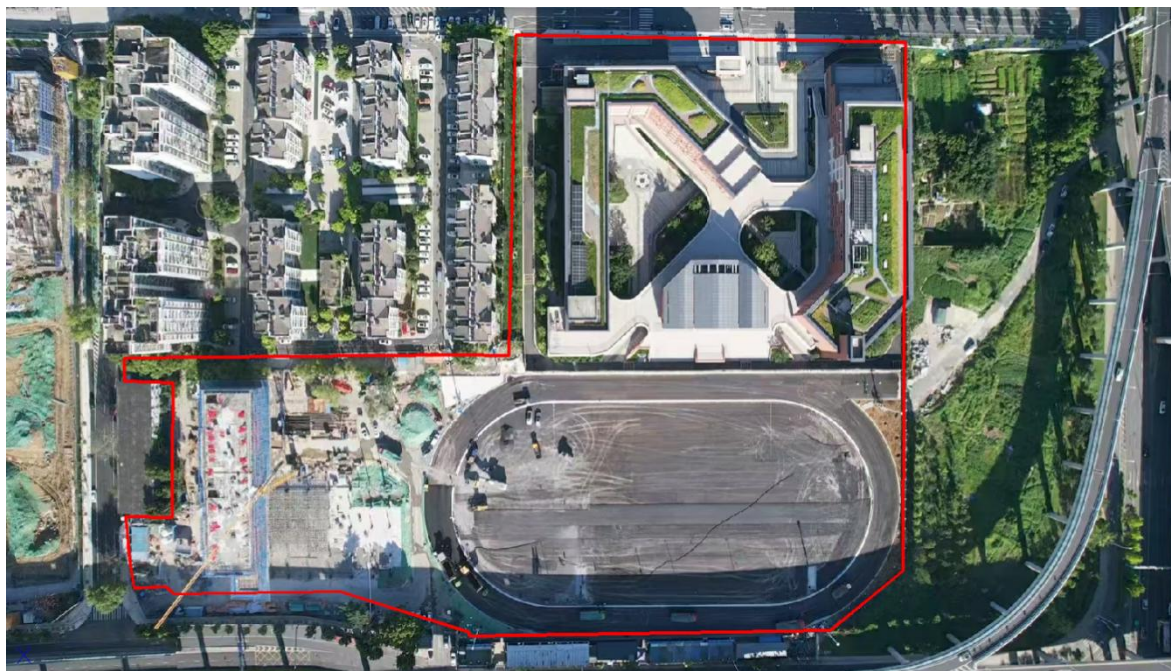
图 1.1 项目建设现状（2026 年 8 月）
