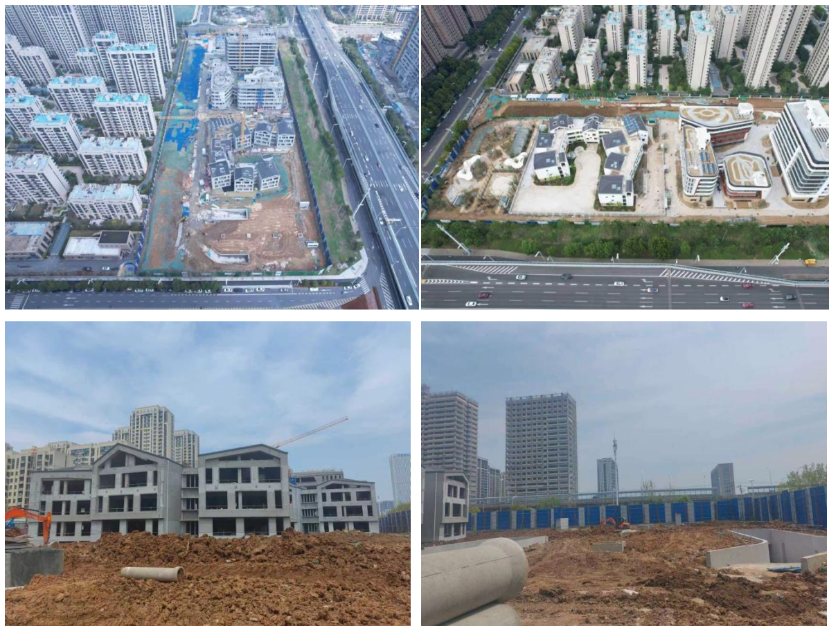
包河大道便民服务中心项目现场照片
