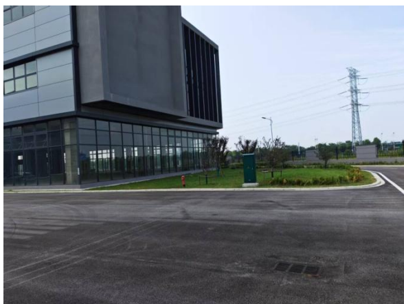
主体工程区绿化
