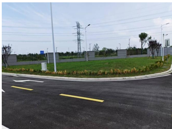
主体工程区绿化
