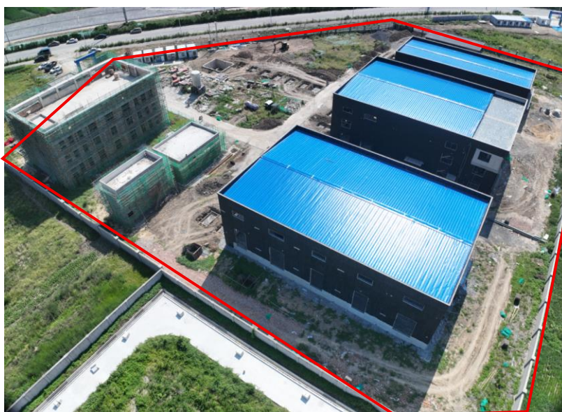
图 1.14 项目区建设现状 (2026 年 8 月)
