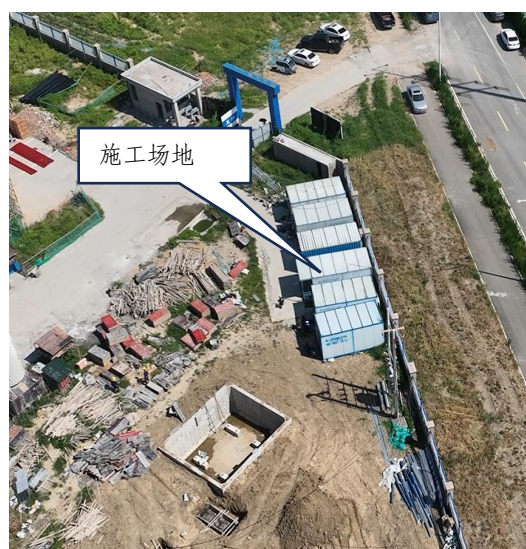
图 1.9 施工场地现状
