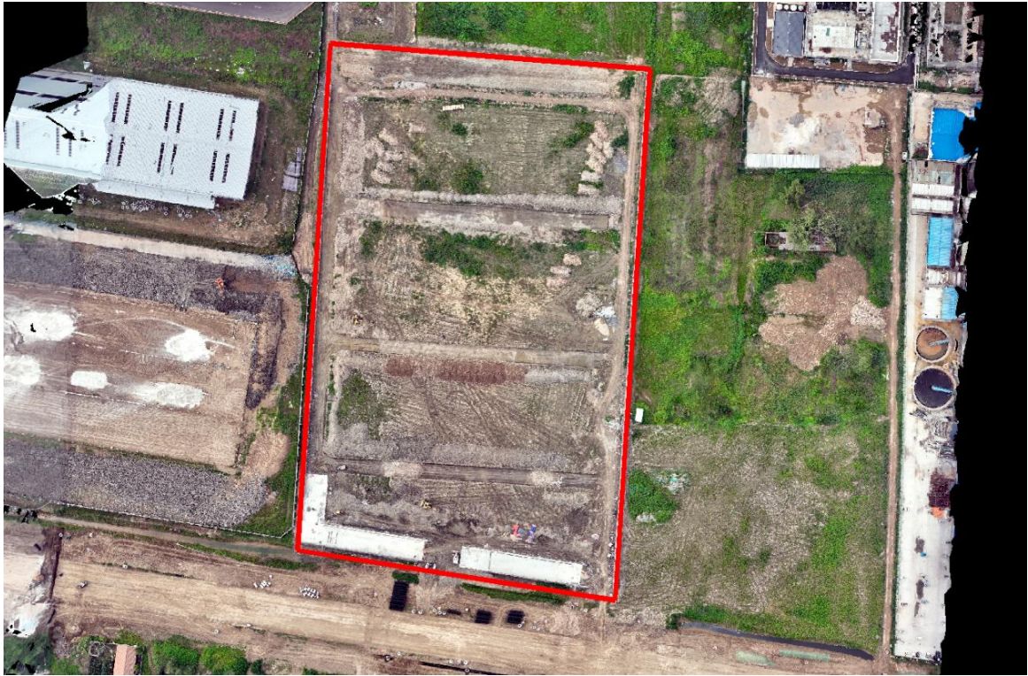
图 1.6 项目建设现状（2026 年 6 月）
