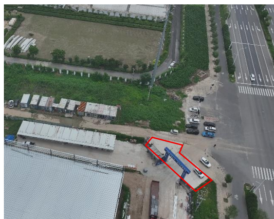
图 1.12 施工道路现状
