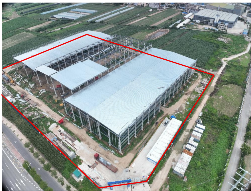
图 1.14 项目区建设现状（2026 年 7 月）
