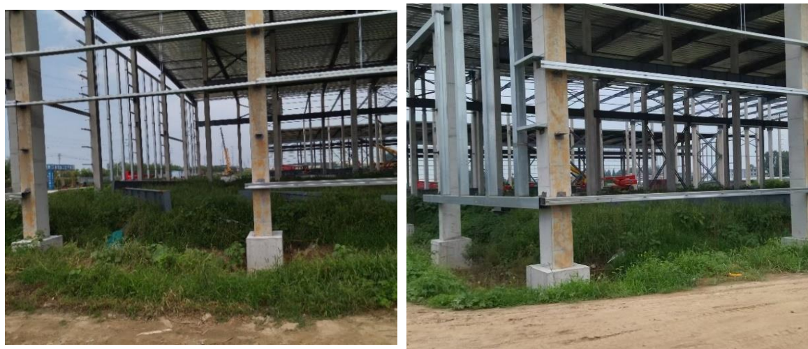
图 1.10 临时堆土现状图
