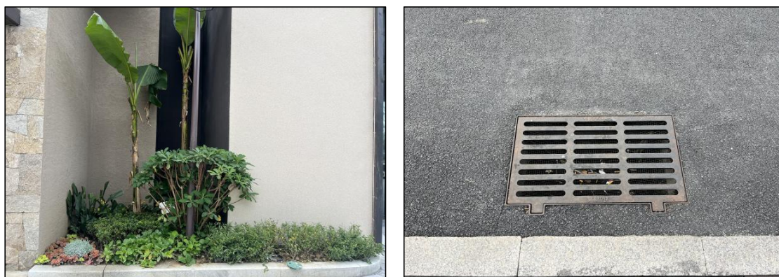
主体工程区植被建设及雨水检查井
