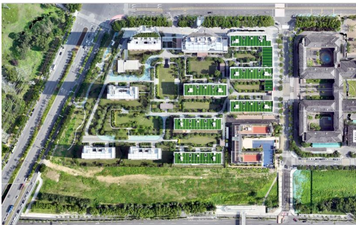
主体工程区建筑物航拍（2025年6月）
