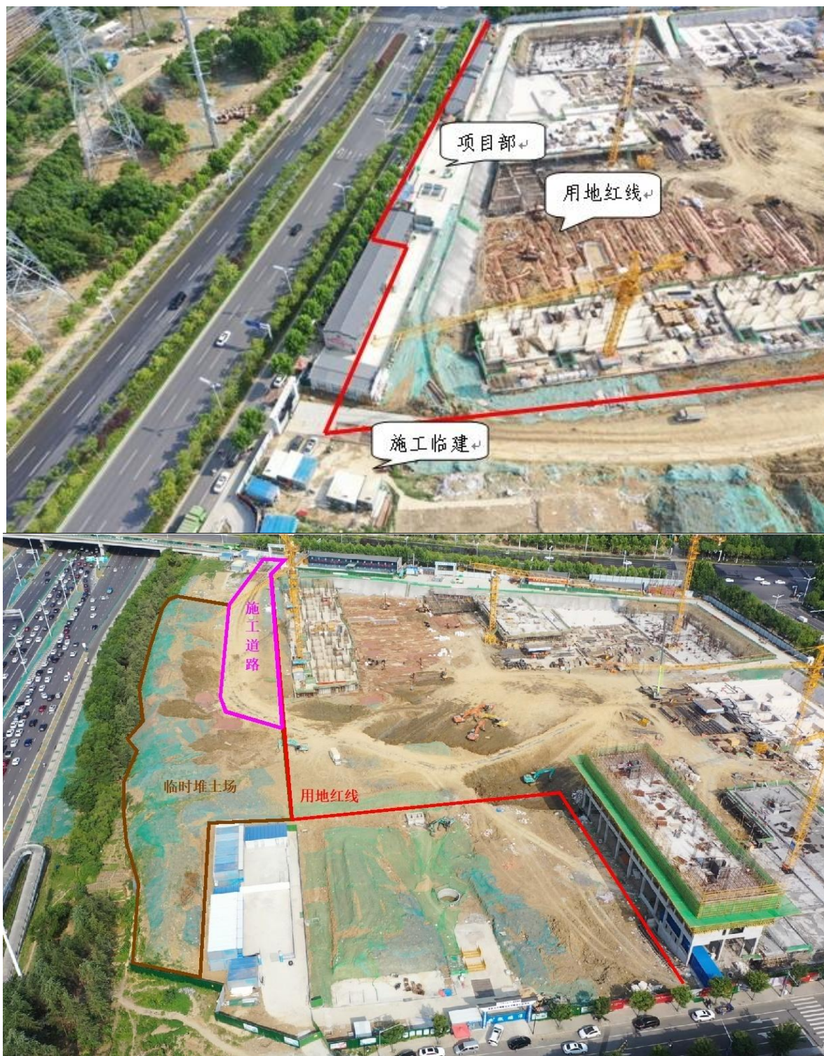
施工组织布置航拍（2022年8月）
