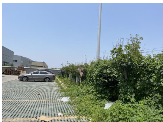
项目区绿化及透水铺砖 (2025.6)
