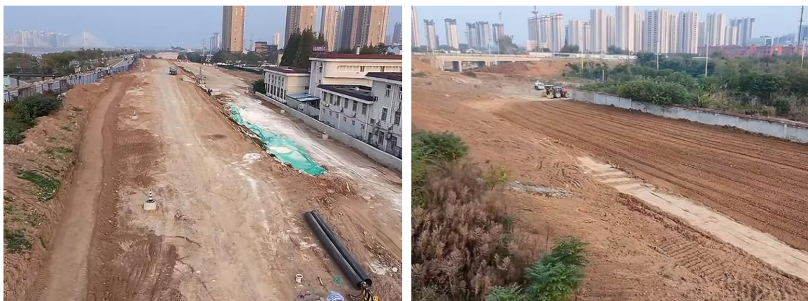
蚌埠靓淮河改造工程交通路段项目现状
