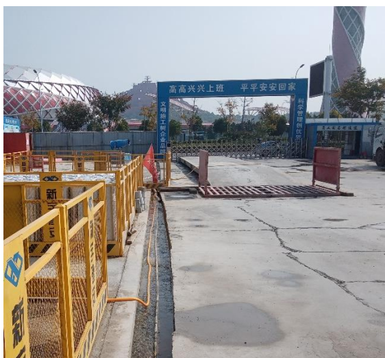
浆砌砖排水沟（2024年11月）
