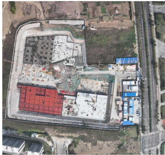
项目建设现状 (2024 年 11 月)
