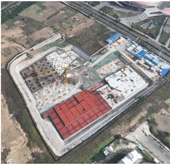
项目建设现状 (2024 年 11 月)
