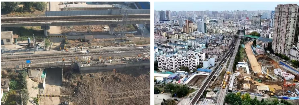
滨河南路（京沪铁路客运线东-解放一路）现状
