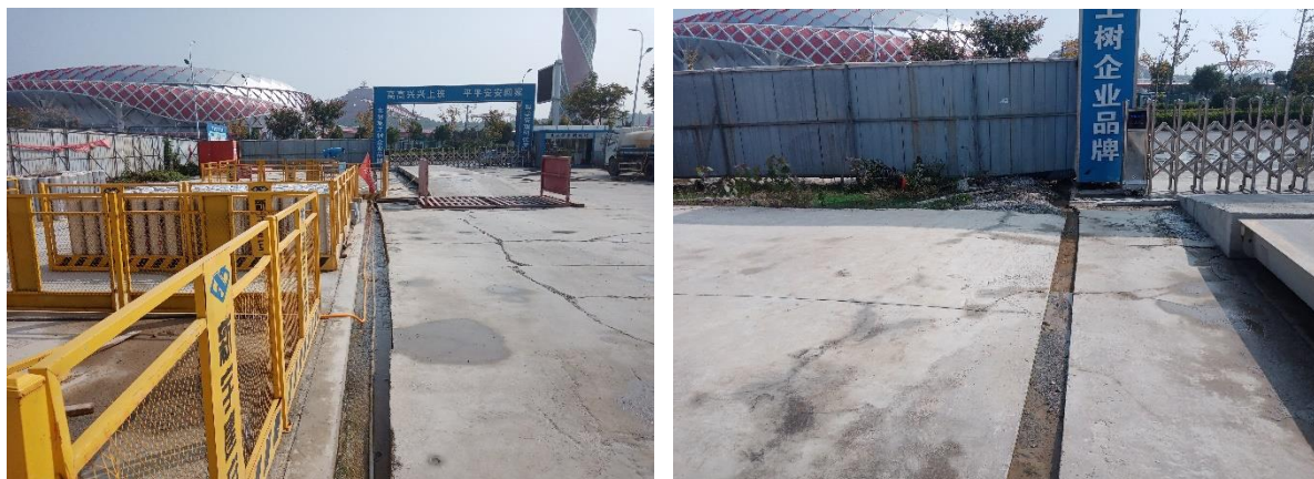
浆砌砖排水沟
