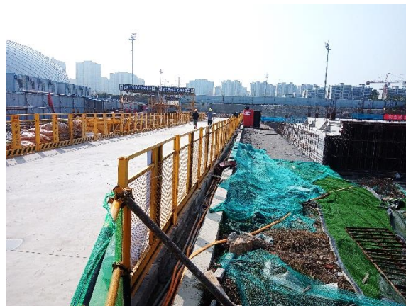
浆砌砖排水沟
