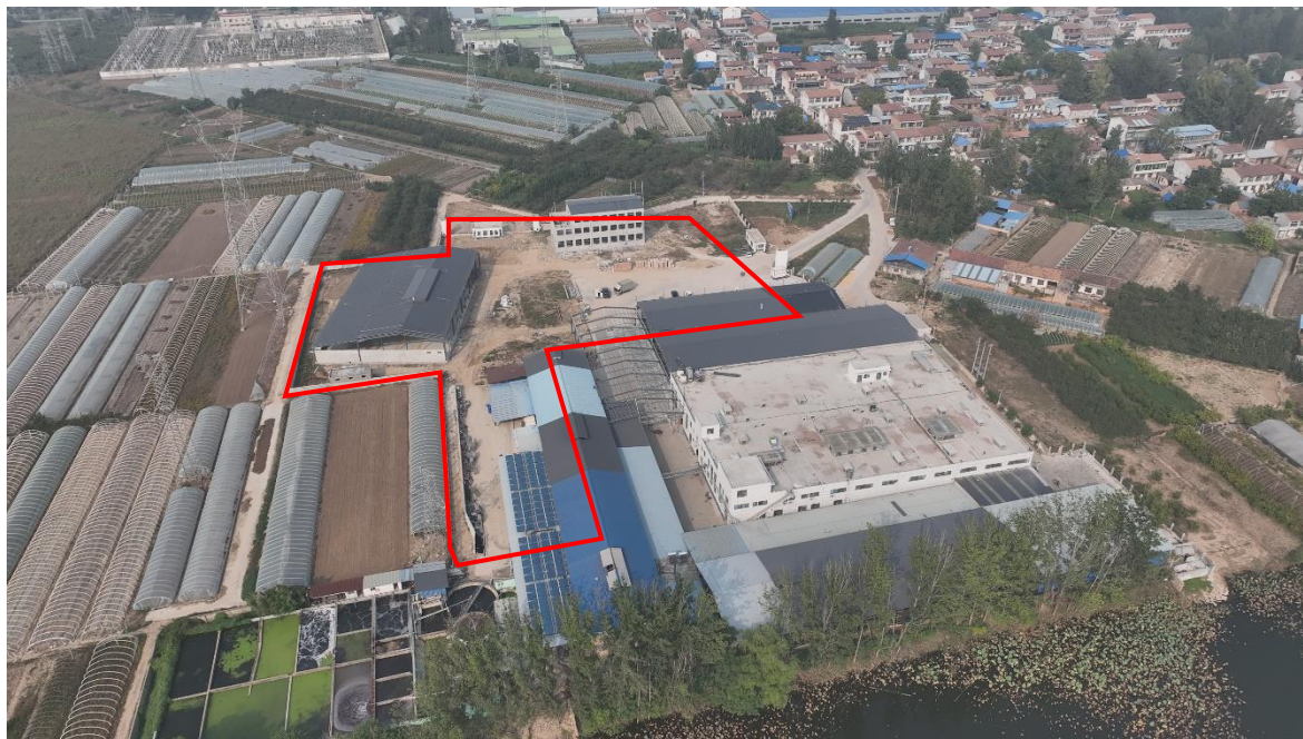
图 1.9 项目区建设现状（2024 年 10 月）
