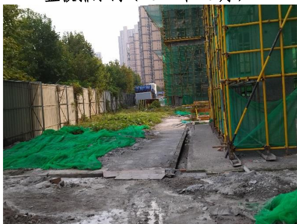
浆砌砖排水沟 (2024 年 10 月)
