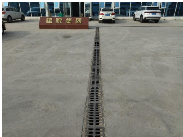
盖板排水沟 (2024 年 10 月)
