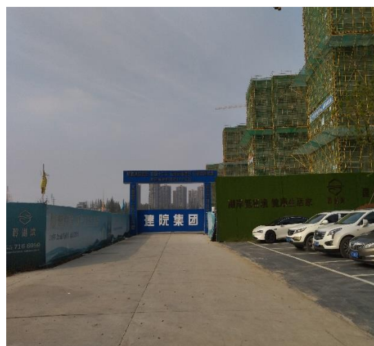
1#施工道路现状
