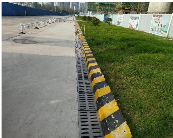
盖板排水沟（2024年10月）
