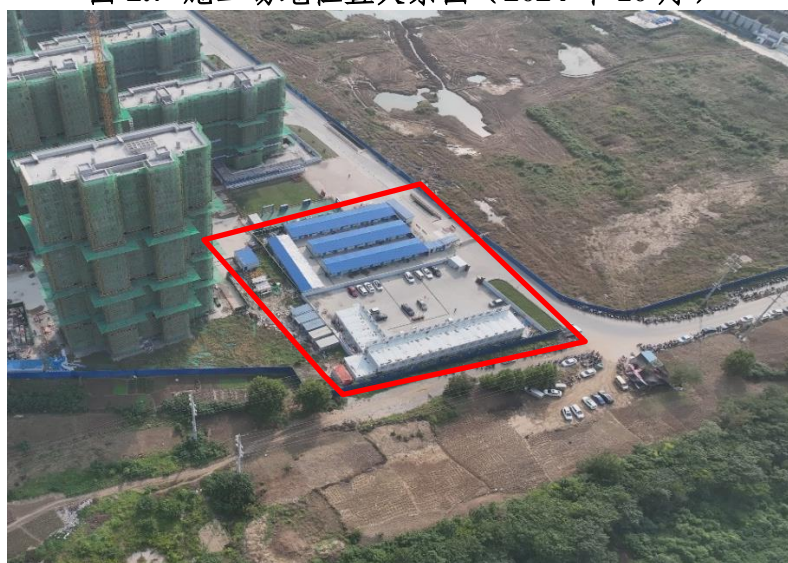
图 2.8 施工场地现状图（2024 年 10 月）
