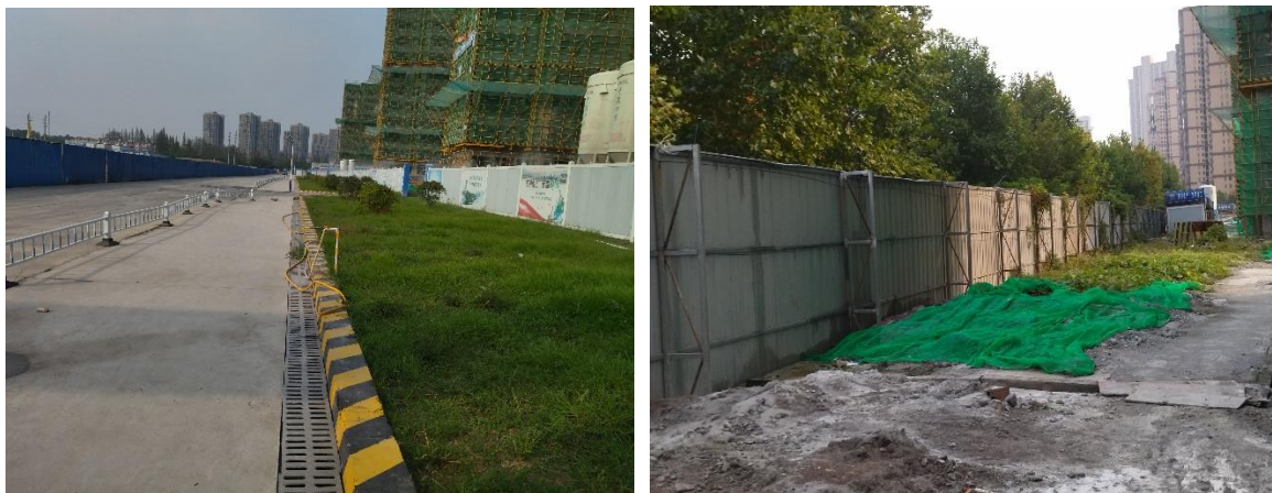
浆砌砖排水沟 (2024年10月)
