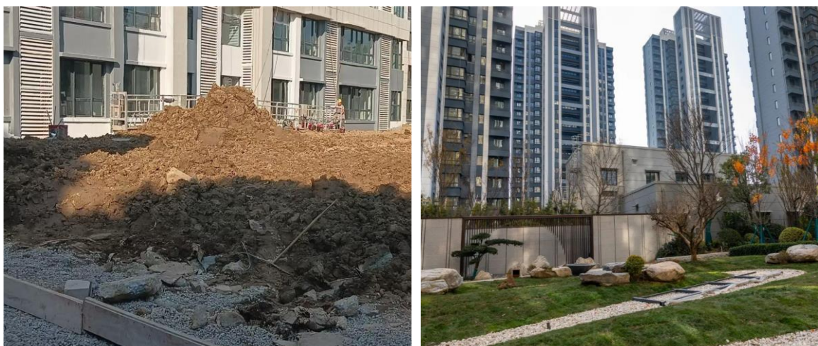
图 3.4 蚌埠淮上万达广场项目建设现状
