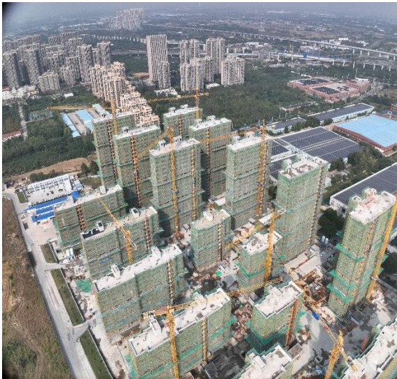
项目建设现状（2024 年 10 月）
