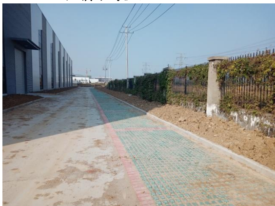
厂区内道路现状 (2024.10.29)
