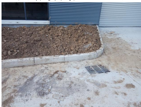
厂区内雨水口现状 (2024.10.29)
