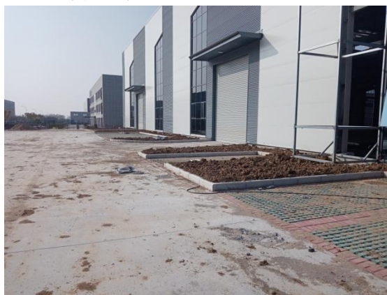
厂区内道路现状 (2024.10.29)
