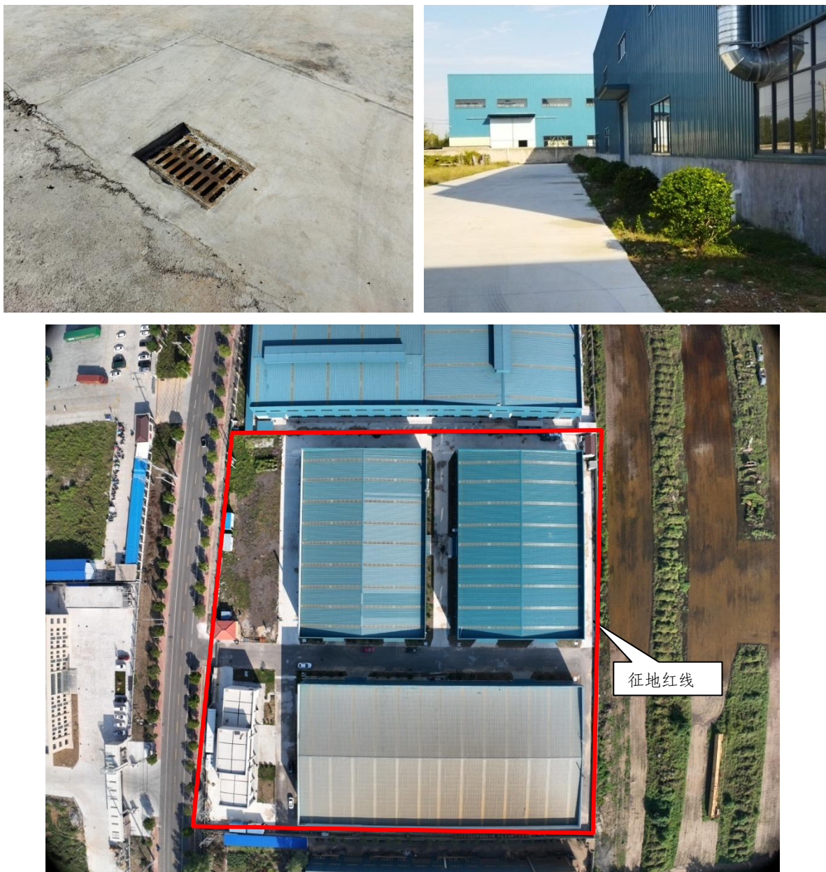
图 1.6 项目建设现状
