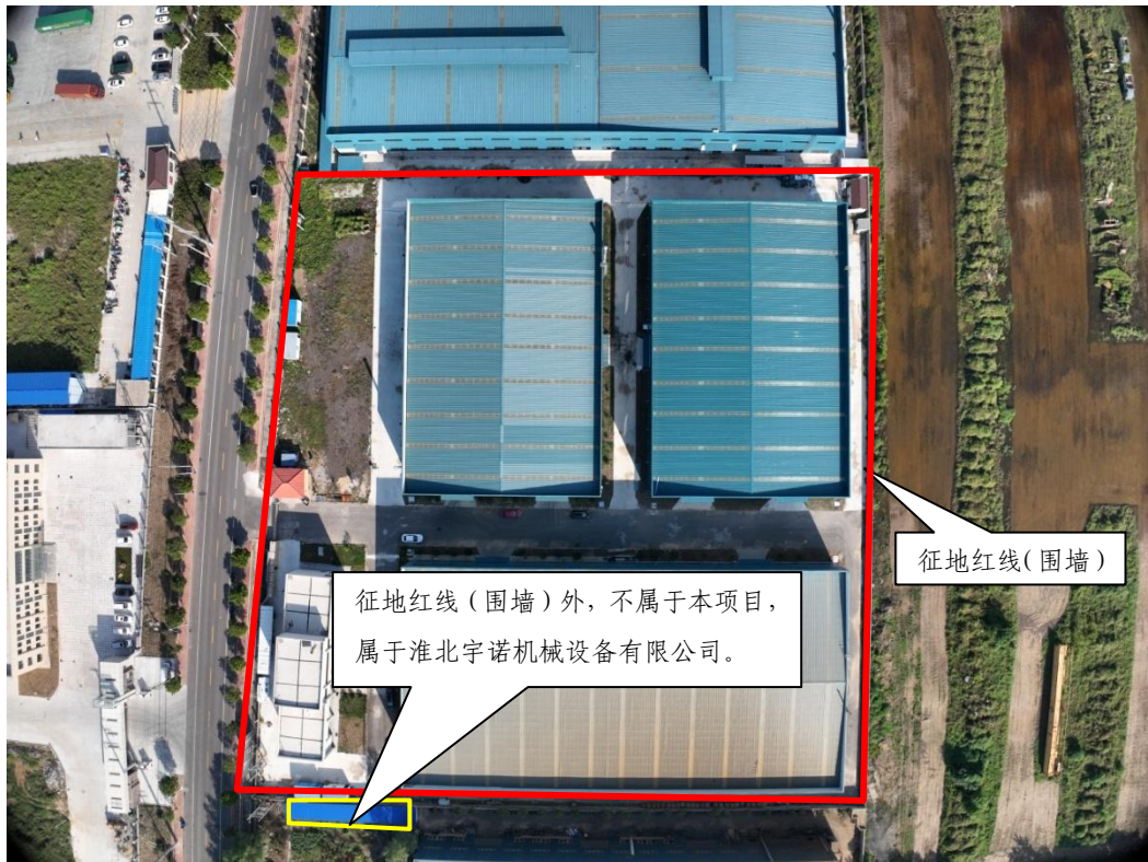
图 1.1 项目建设现状
