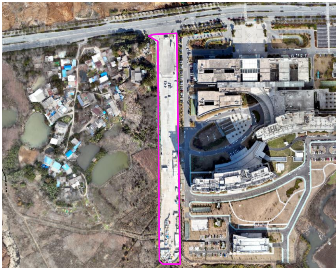
图 2.15 湖南东路--桃李山路段现场航拍图
