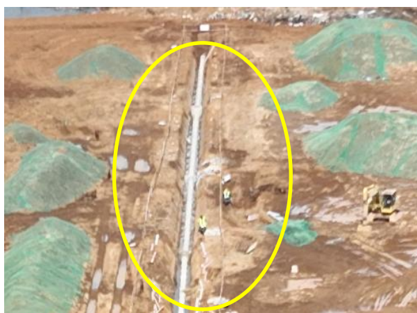
布设雨水管以及雨水井
