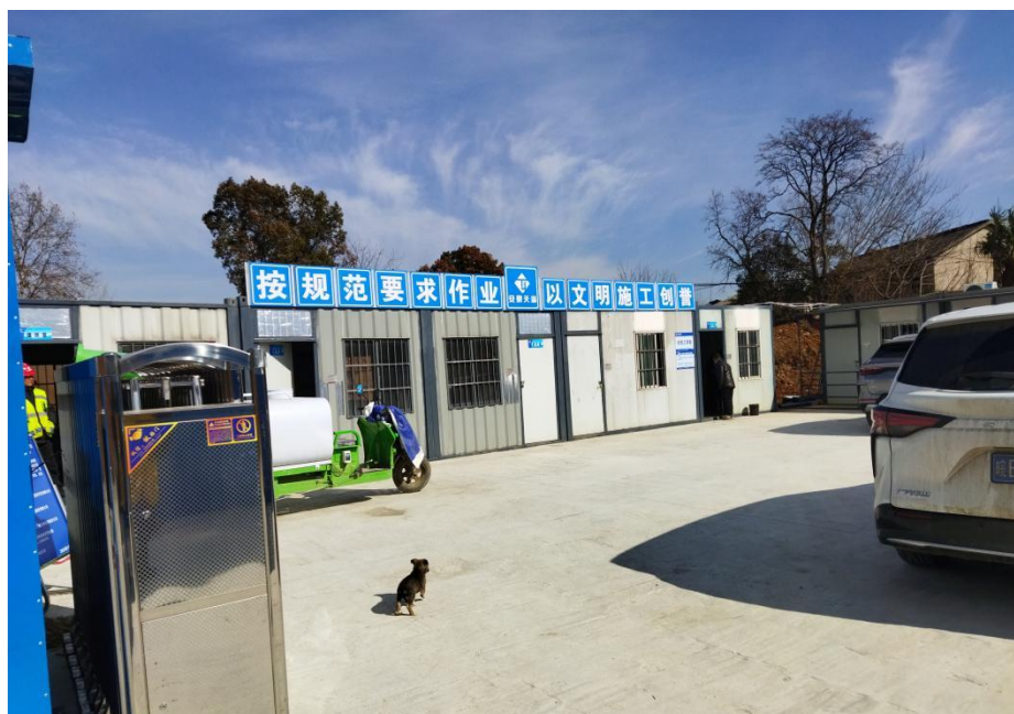
图 2.17 施工生产生活区现场影像
