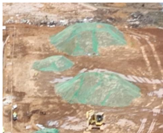
临时苫盖措施
