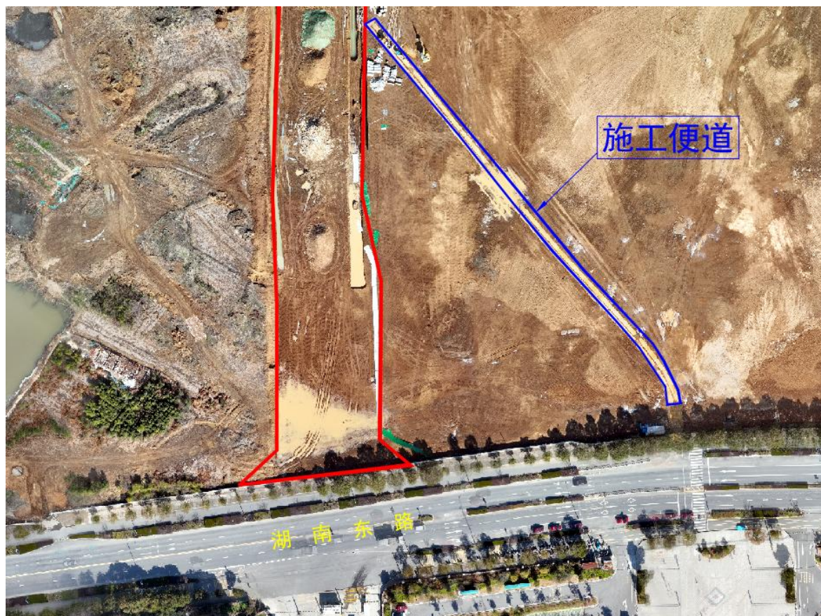
图 2.20 湖南东路-桃李山路段施工便道航拍影像
