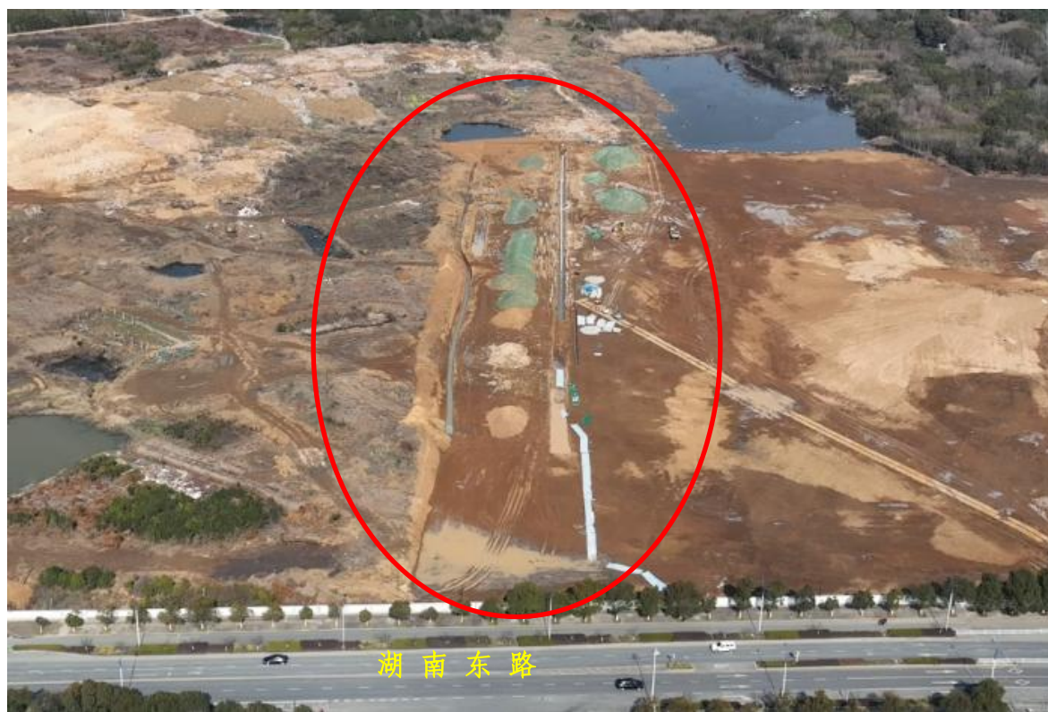
图 2.14 秀山大道--湖南东路段现场航拍照片
