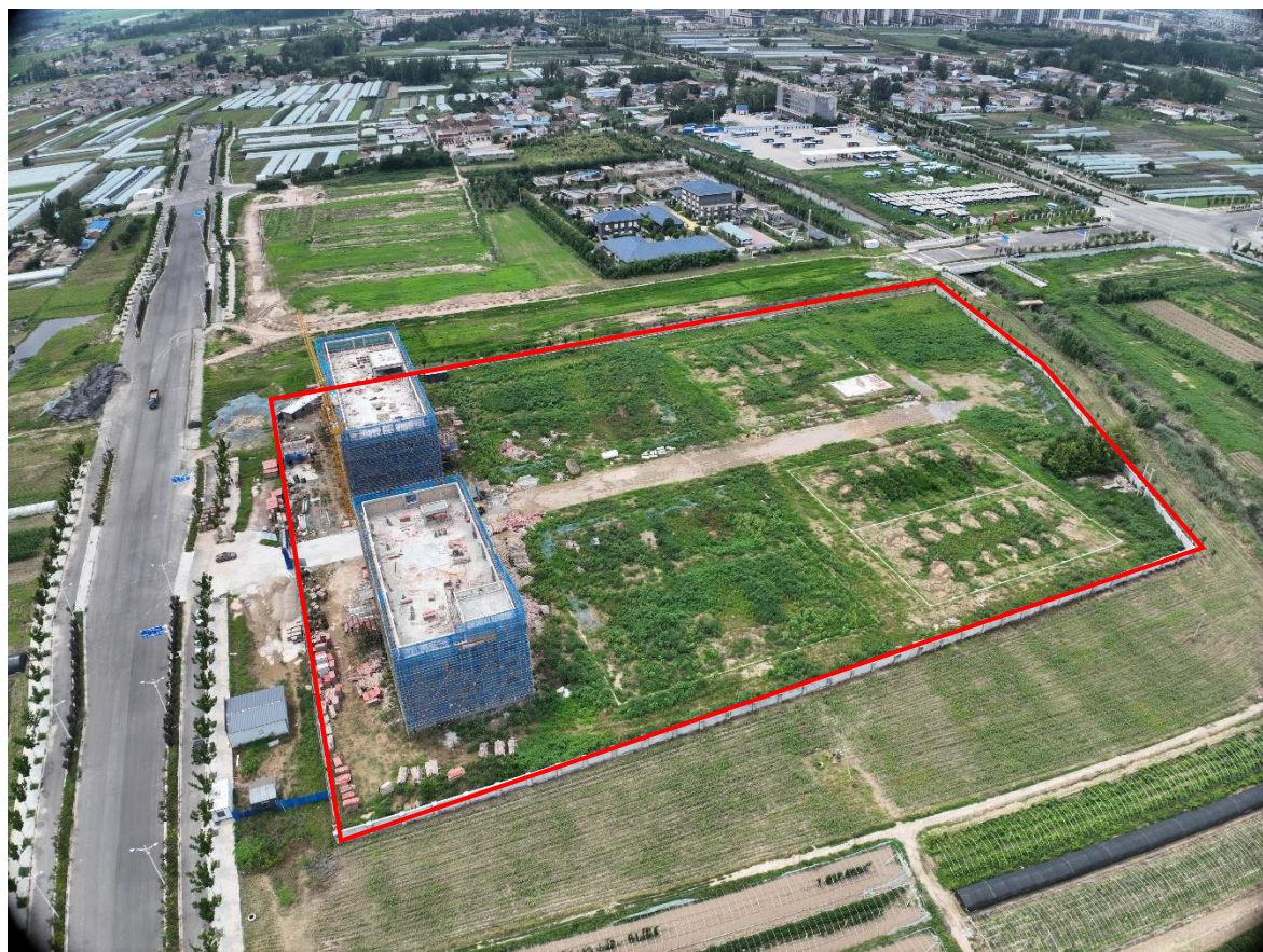
图 1.10 项目区建设现状（2024年8月）
