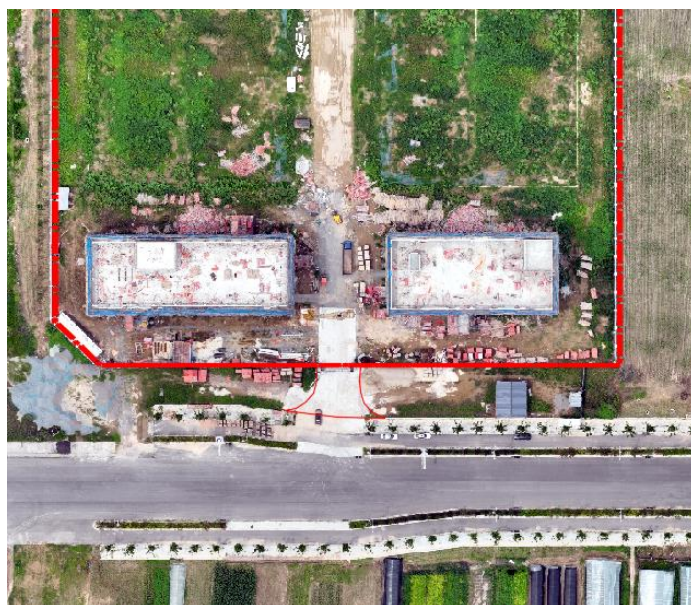
图 1.9 施工道路现状（2024 年 8 月）
