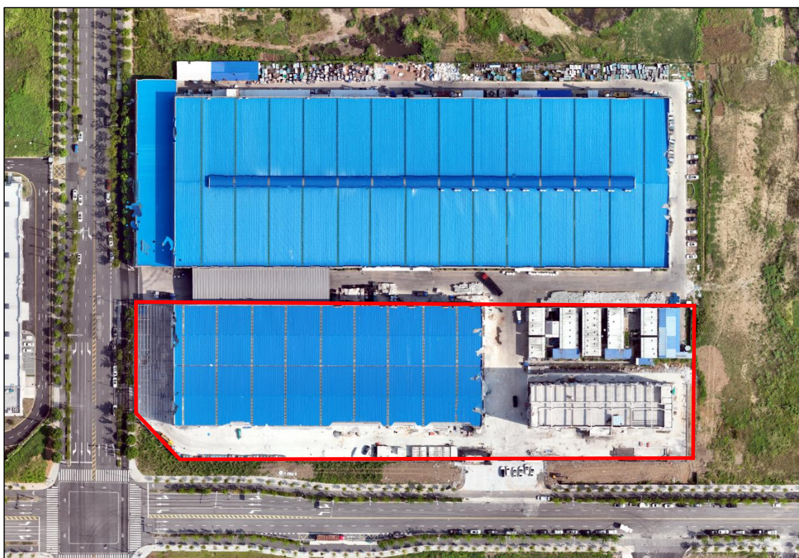
图 1.1-2 项目施工现状图（正射套红线 2024.8）
