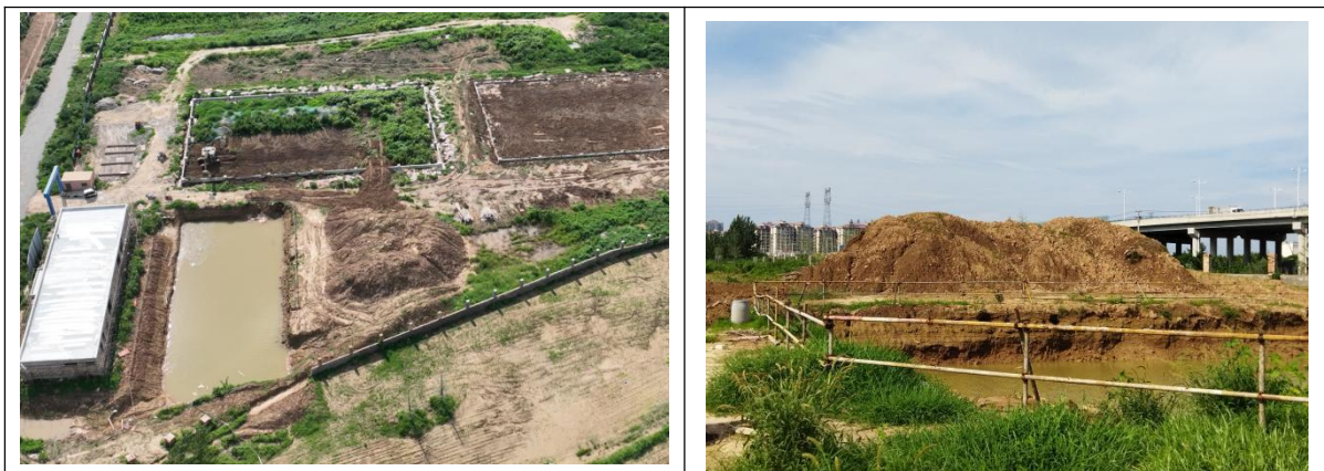
图 1.10 临时堆土场现状图
