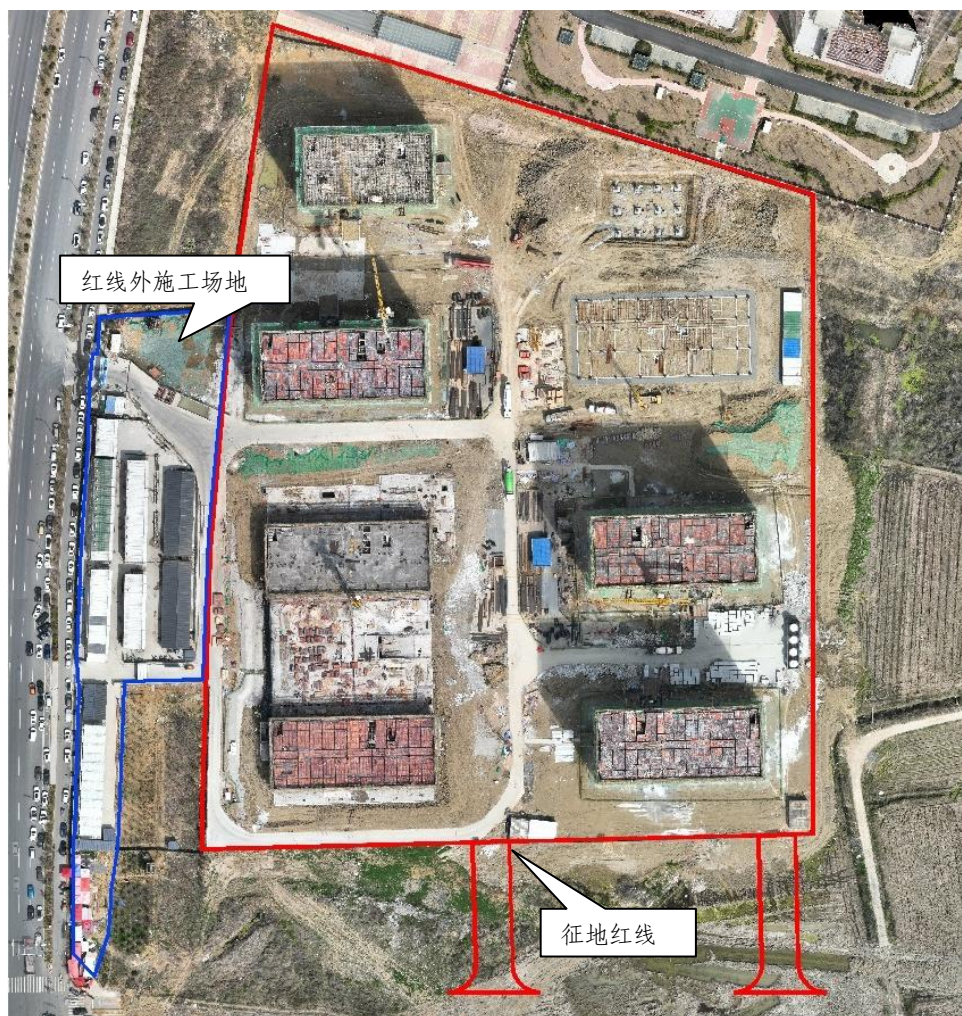
图 1.1 项目建设现状
