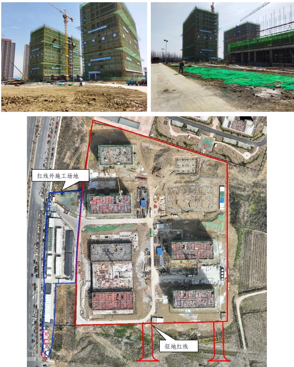
图 1.6 项目施工进度现状
