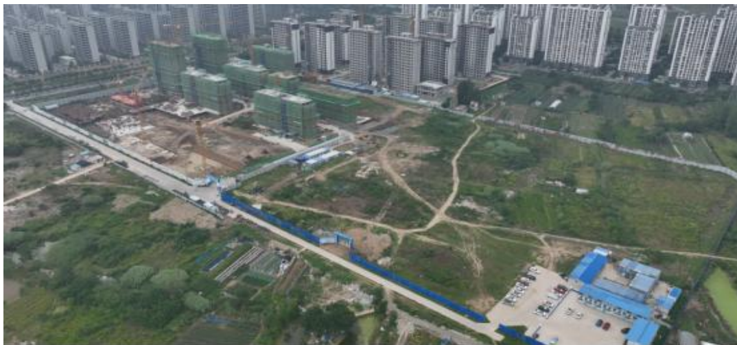
图 3.2 山水拾光小区项目现场照片
