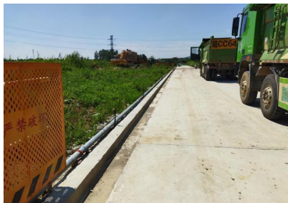
临时排水沟(2024年7月)
