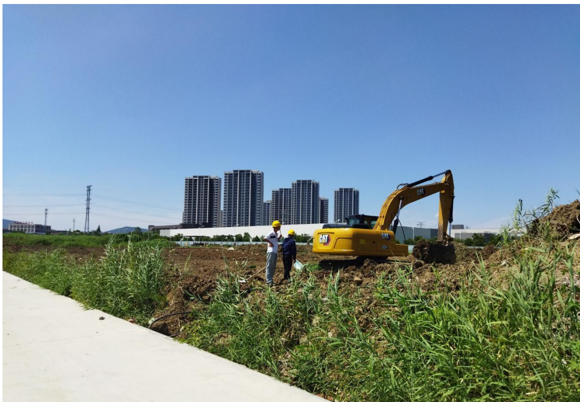
图 2.17 基础开挖（2023 年 10 月）
