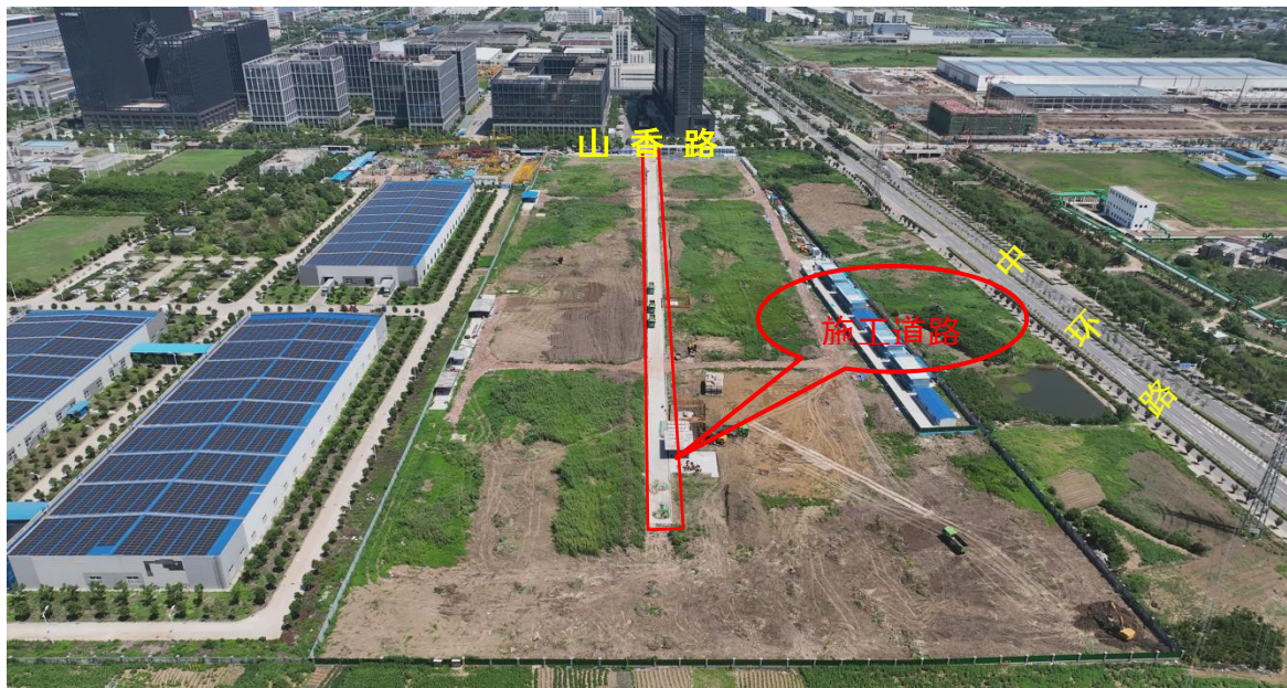
图 2.15 施工道路示意图（2024 年 7 月）
