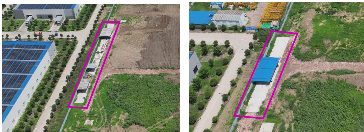
两处钢筋堆放与加工场地（2024年7月）
