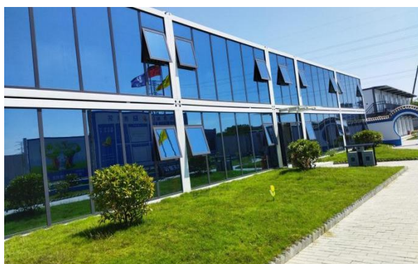
项目部临时绿化(2024年7月)
