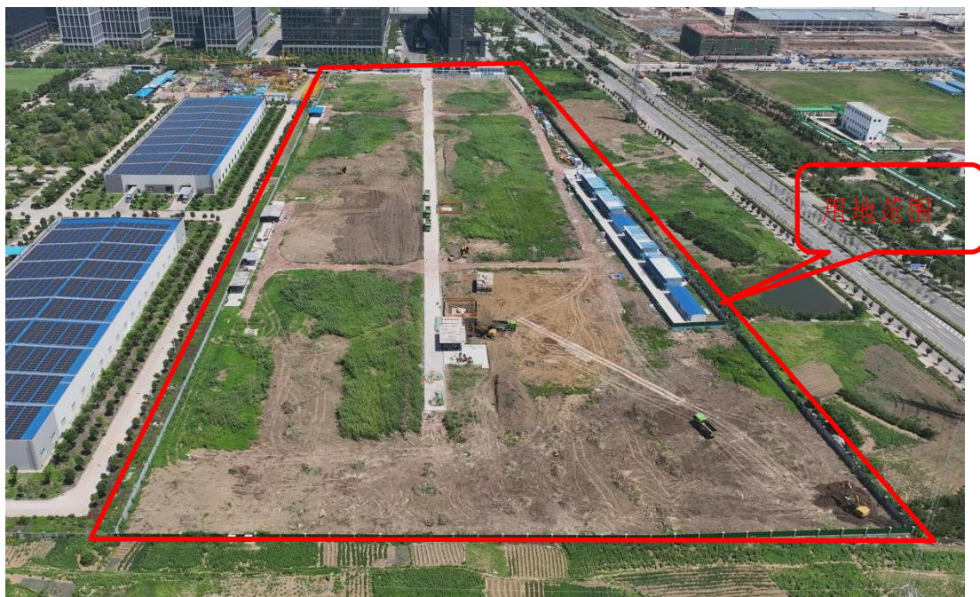
图 2.16 施工现场航拍图（2024 年 7 月）
