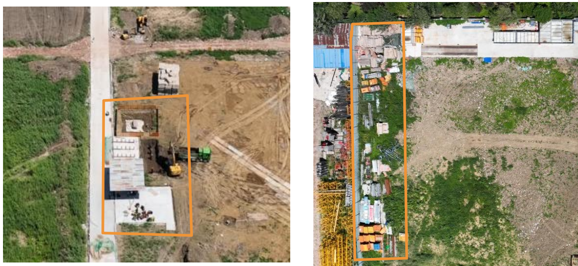
材料堆放区现场照片（2024年7月）
