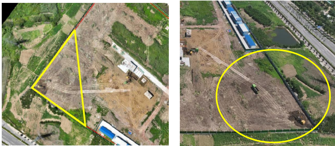
图 2.17 施工临时占用场地现场照片（2024 年 7 月）
