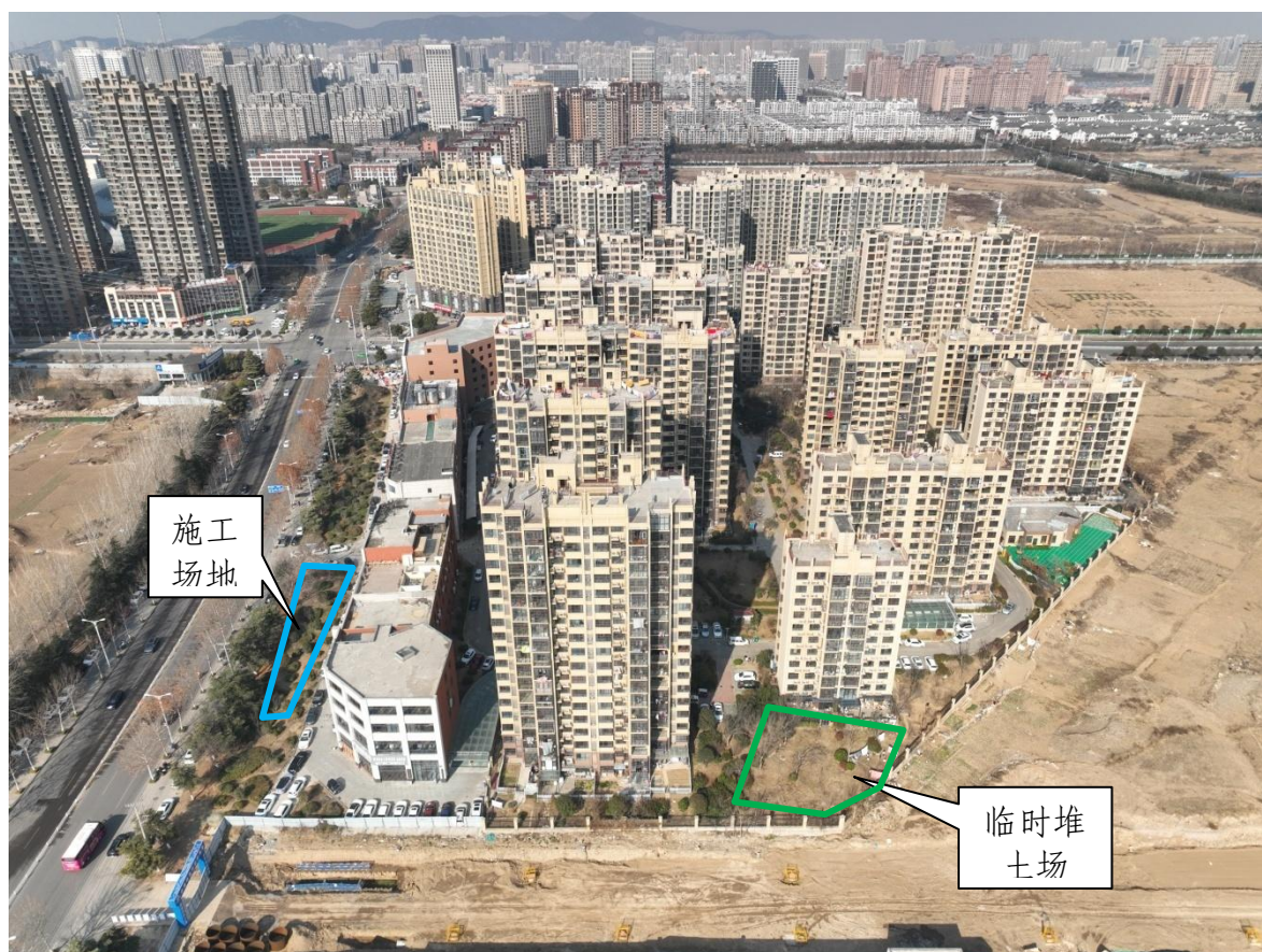
施工组织布置现状（2024 年 1 月）
