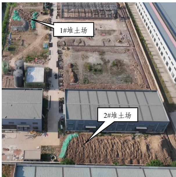
图 1.16 临时堆土场现状
