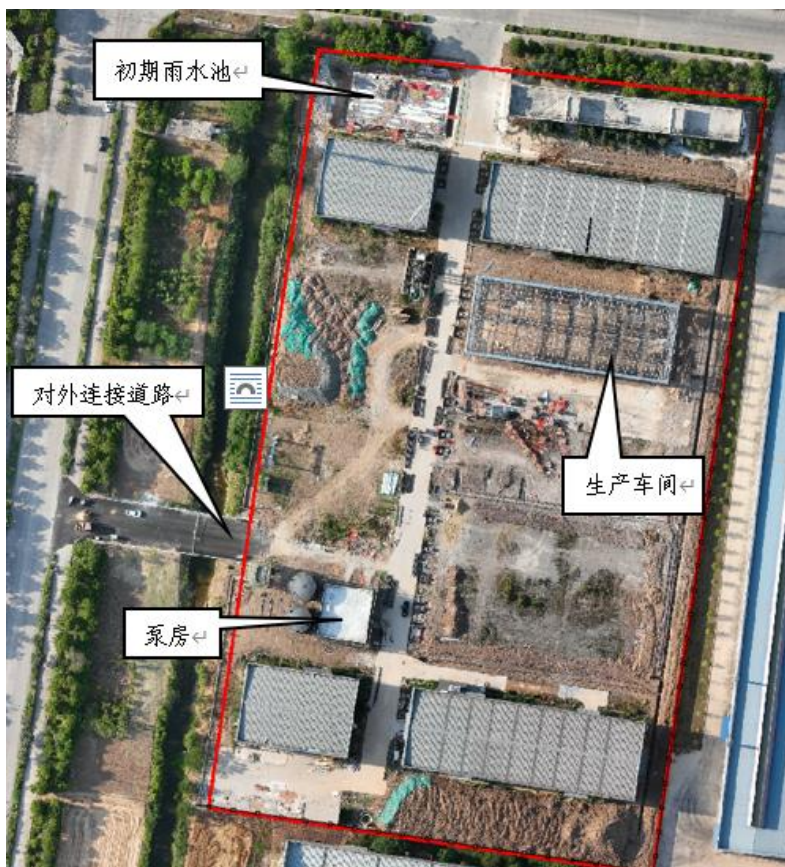
图 1.2 项目区现场影像（2024 年 5 月）
