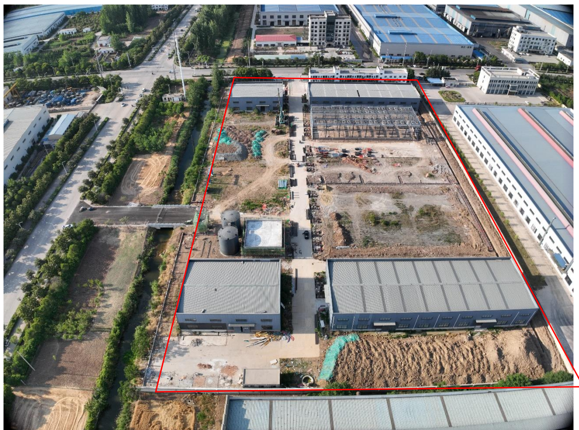
图 1.19 项目区建设现状（2024 年 5 月）
