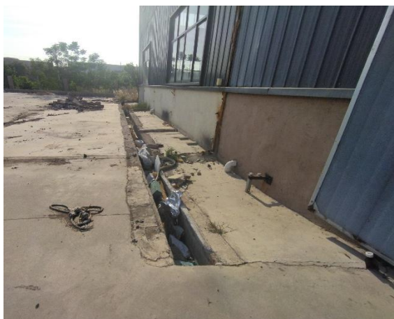
盖板雨水沟（永临结合）
