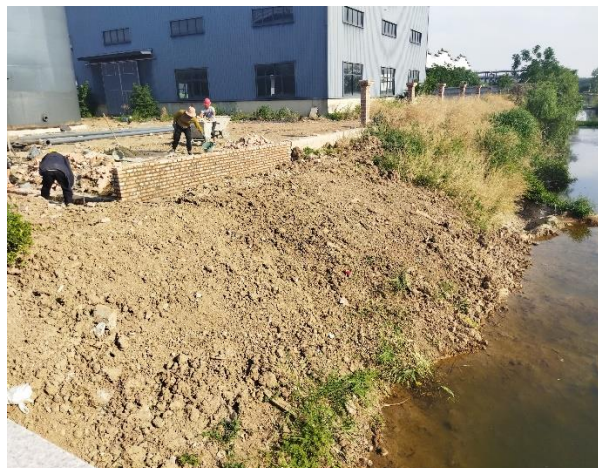
图 1.18 扰动边坡现状
