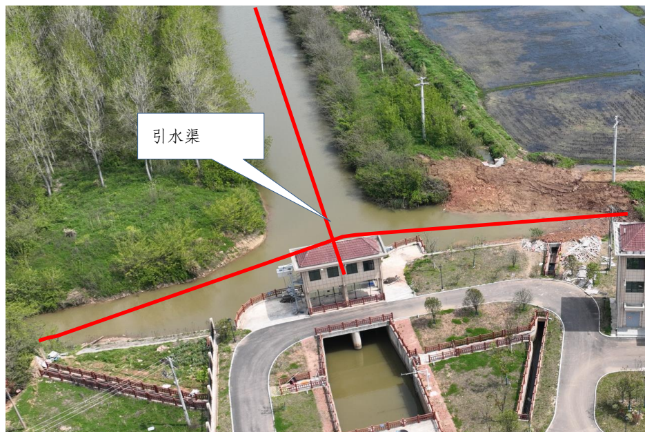
图 1.6 排涝引水渠现状
