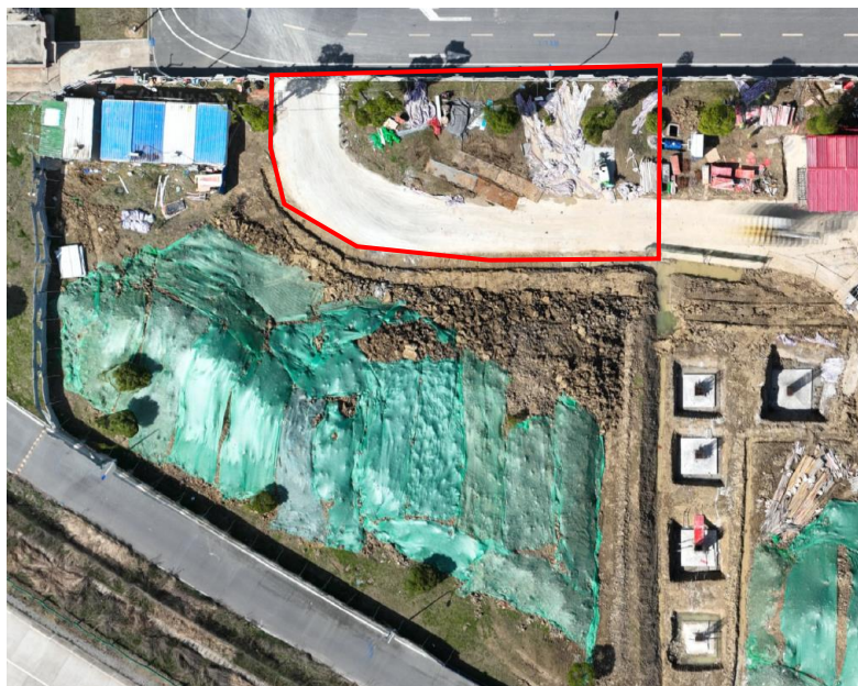
图 1.12 施工道路现状图
