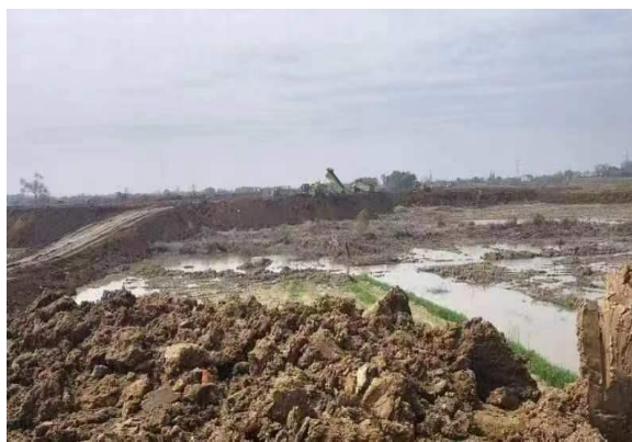
弃土场现场照片
