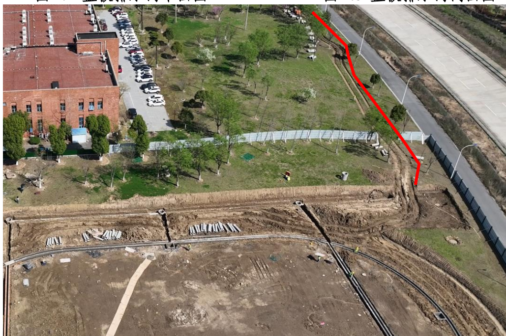
图 1.9 红线外雨水管线
