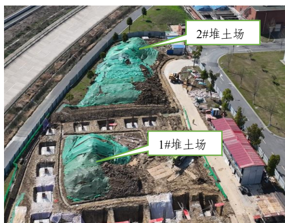
图 1.11 临时堆土场现状
