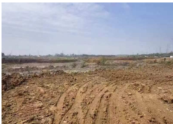
弃土场现场照片
