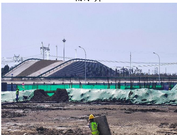
足球场基坑边坡苫盖
