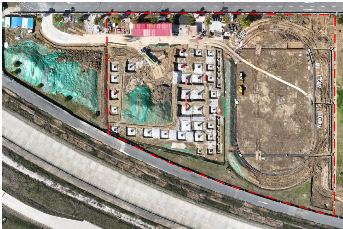
图 1.13 项目区现场影像（2024 年 4 月）
