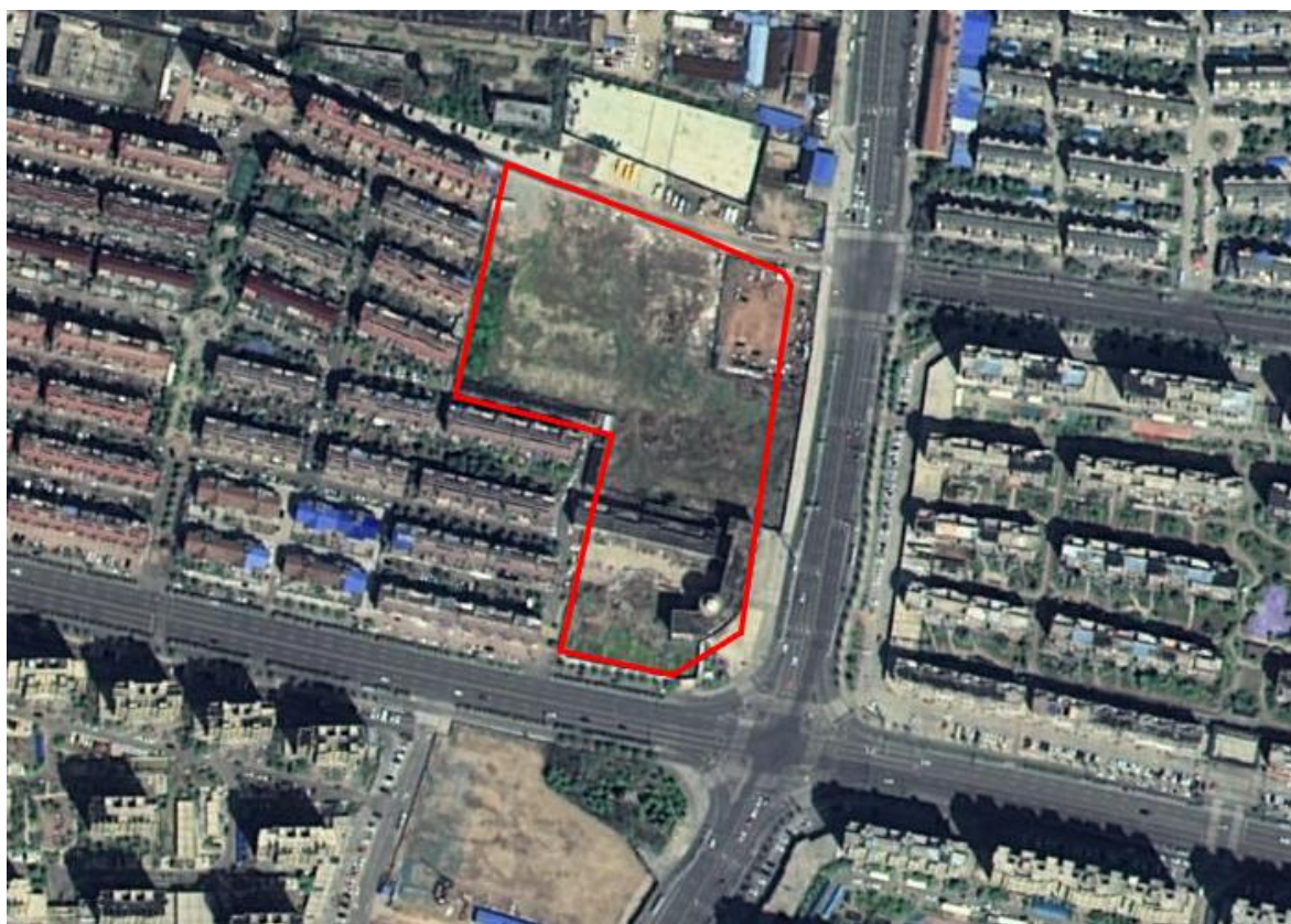
图 1.4 项目区地形地貌图（施工前）
