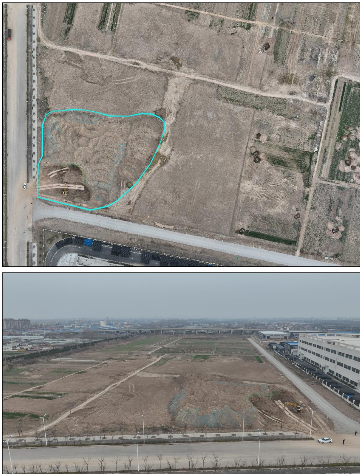
图 1.11 临时堆土场现状
