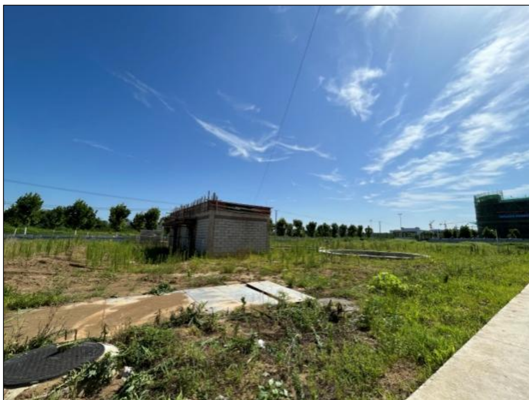
消防泵房和消防水罐
