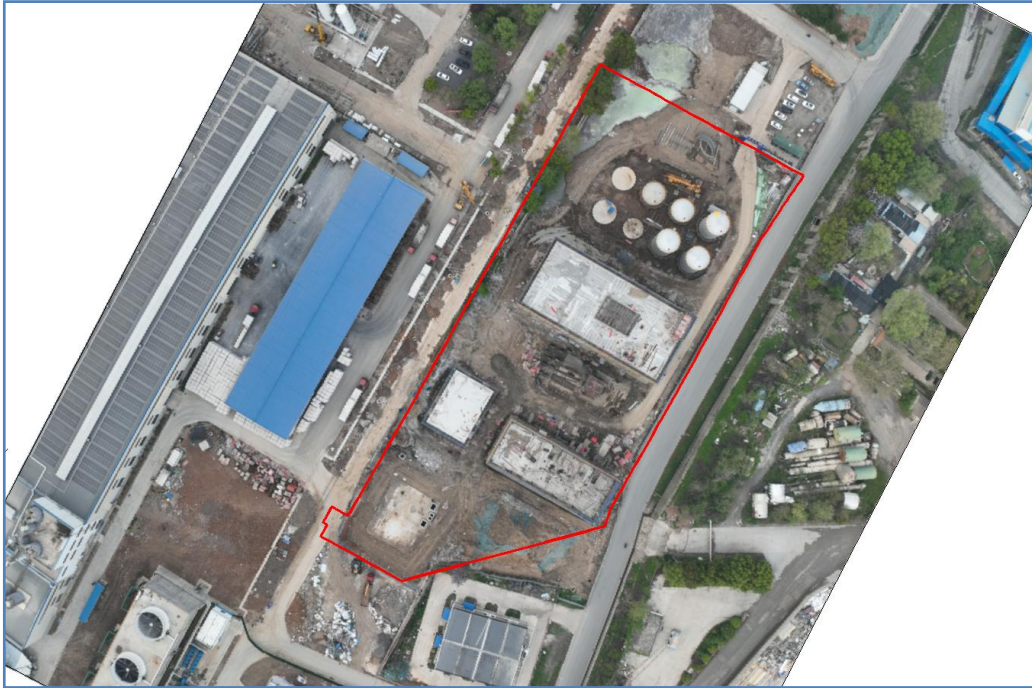
图 1.1 项目现状正射图（2024 年 3 月）
