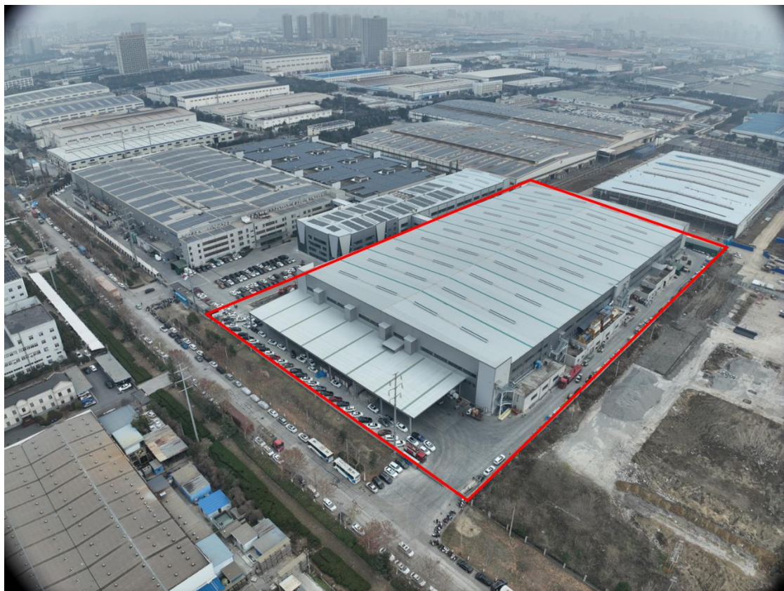
图 1.9 项目区现场影像（2023 年 12 月）
