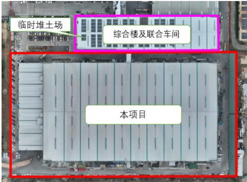
图 1.7 本项目与临时堆土场现状
