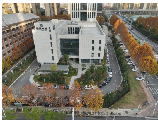
项目航拍图（主体工程区）
