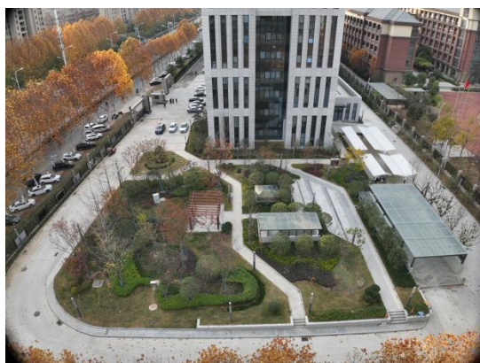
项目航拍图（主体工程区）
