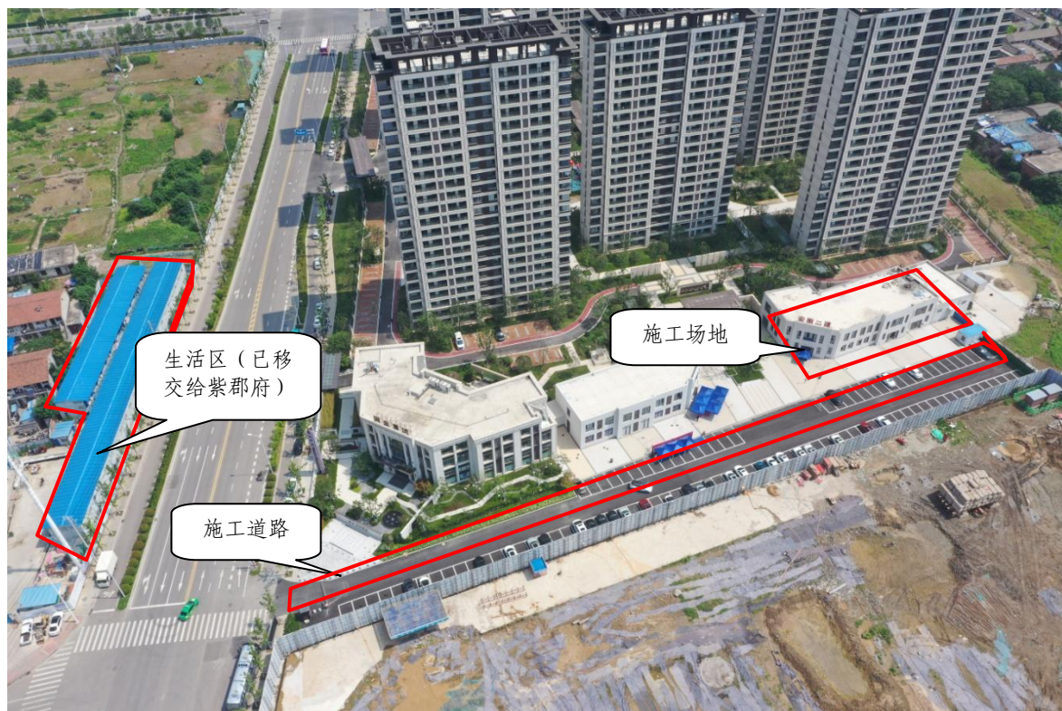
施工组织完工后恢复现状（2023.6）
