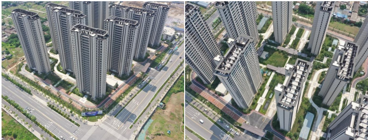
项目区完工后航拍（2023.6）
