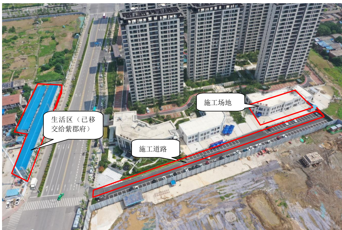
施工组织完工后恢复现状（2023.6）
