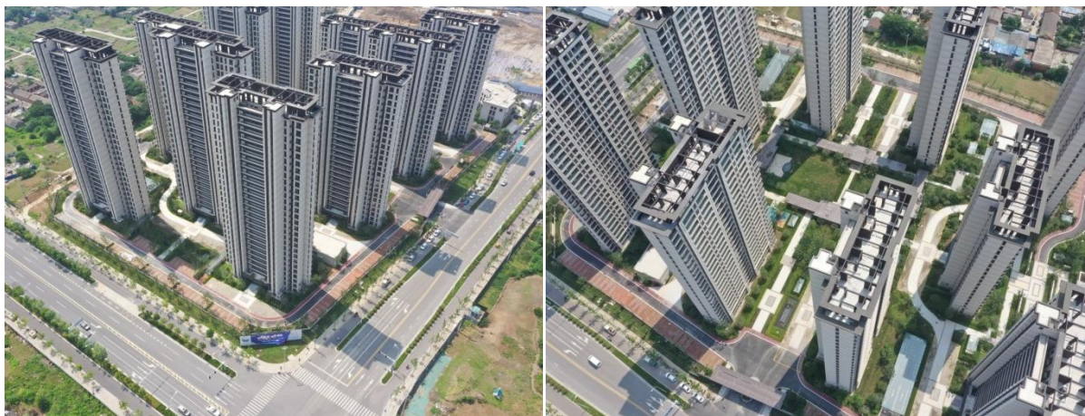
项目区完工后航拍（2023.6）
