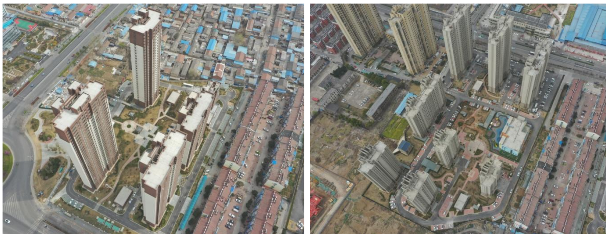
项目区完工后航拍（2023.3）
