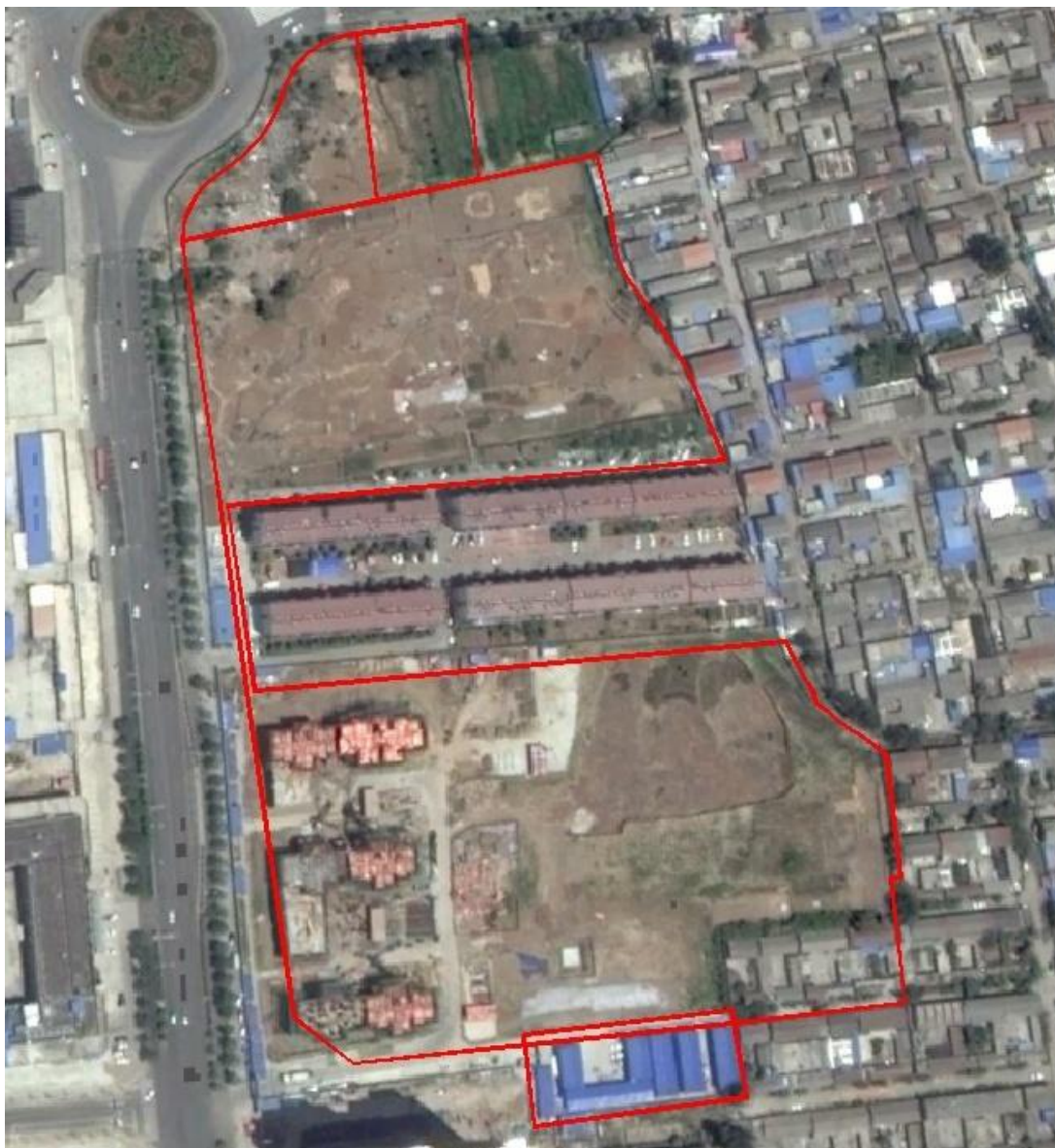
图 1.4 项目区施工前地形地貌图
