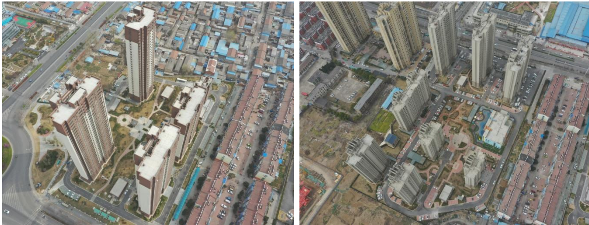
项目区完工后航拍（2023.3）
