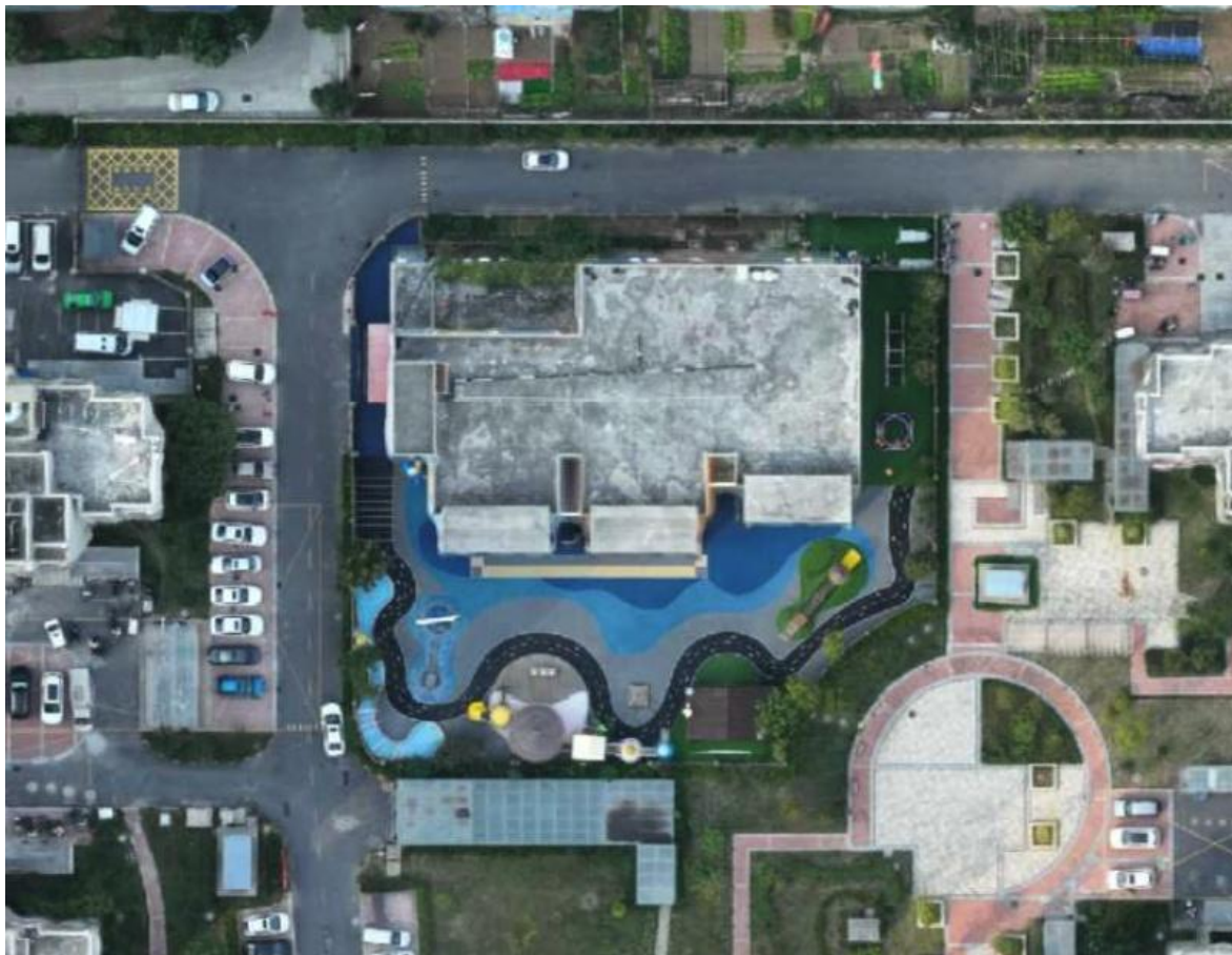
幼儿园完工后航拍图（2023.10）
