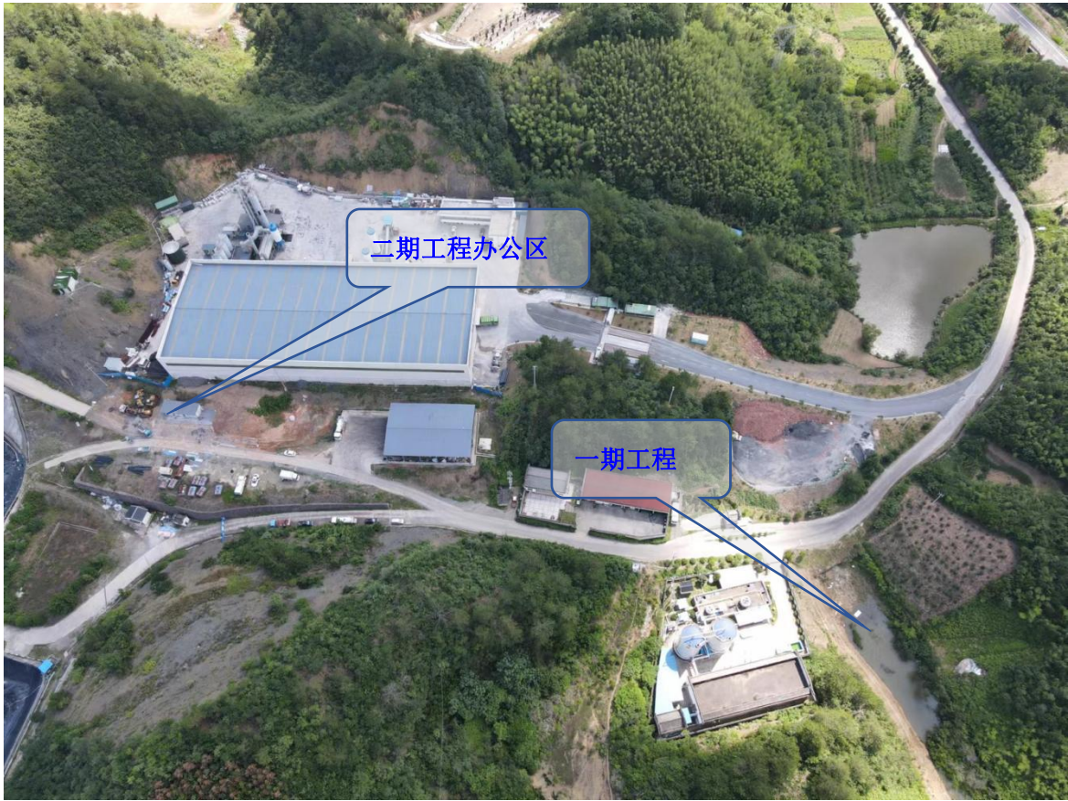
图 1.1-1 项目现场航拍图
