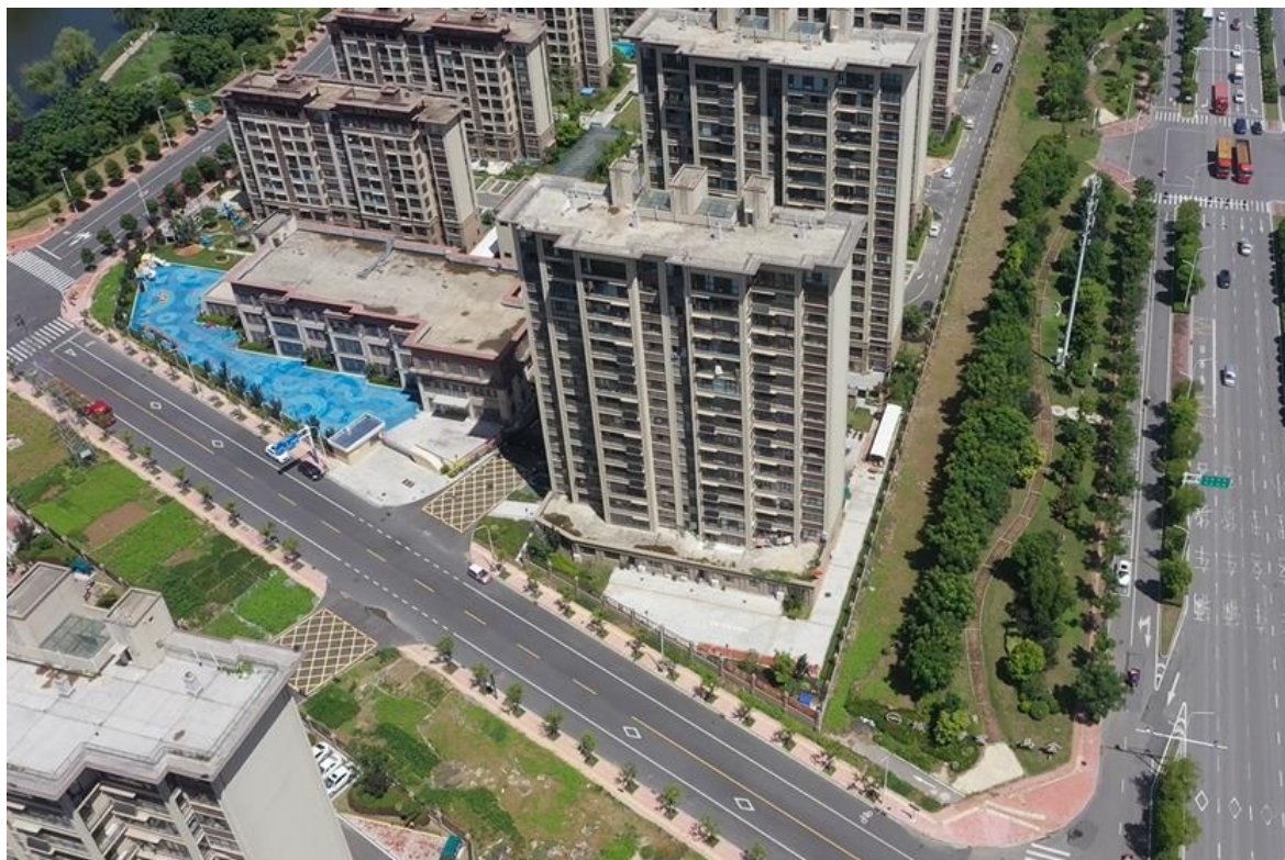
图 2.12 施工便道现状
