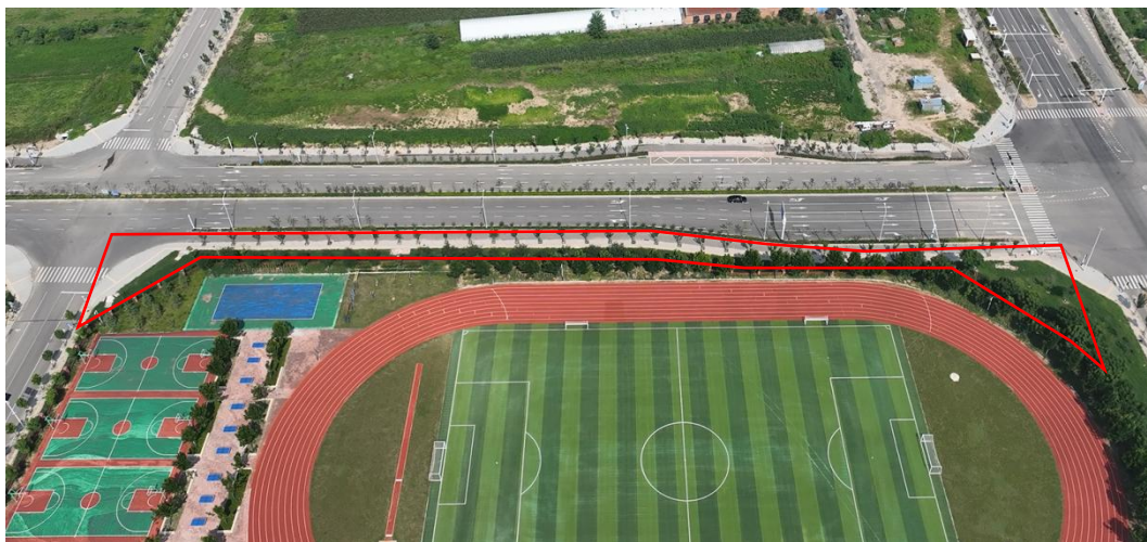
图 1.1-2 施工道路现状图（2023.10）
