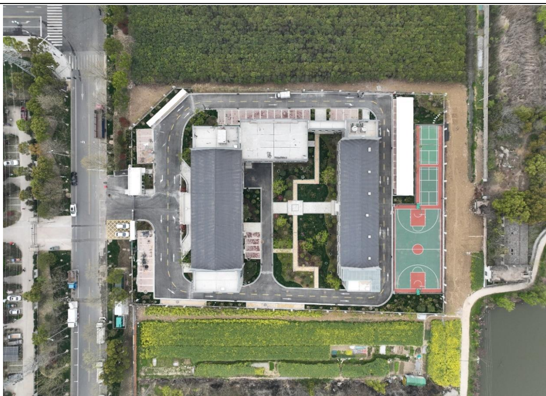
项目建设现状（2023 年 3 月）
