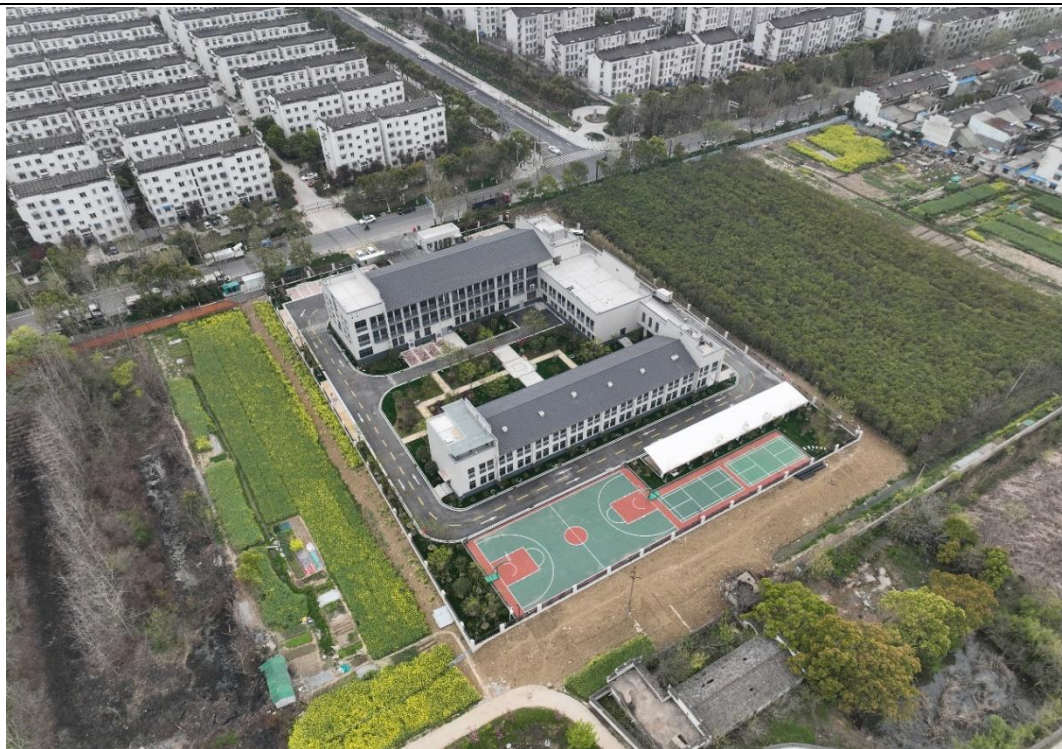
项目建设现状（2023 年 3 月）
