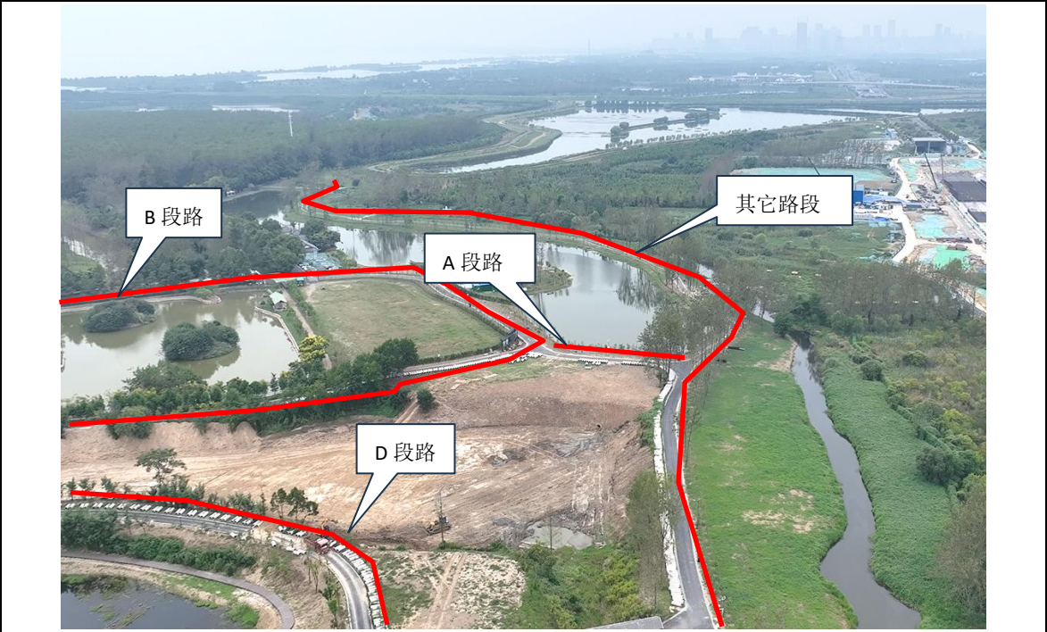
项目建设现状
