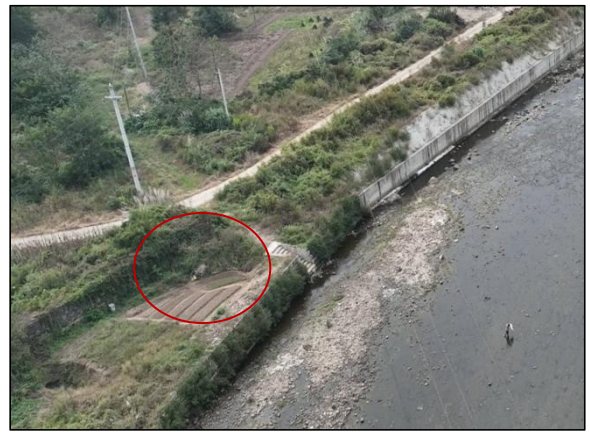
K13+939~K14+738 段挡墙施工场地现状
