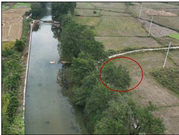
K8+672~K8+982 段挡墙施工场地现状
