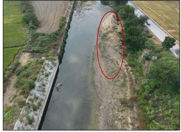
K4+630~K5+150 段挡墙施工场地现状
