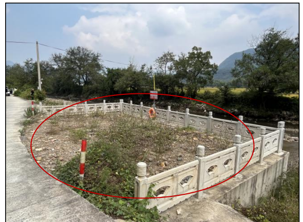
K11+380 拦河堰施工场地现状
