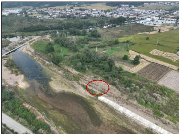
K12+236~K12+436 段堤防施工场地现状
