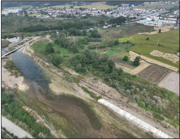
K12+236~K12+436 段堤防施工便道现状
