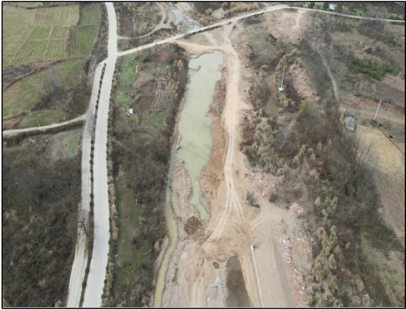
K12+236~K12+436 段堤防施工便道 (2022.10)
