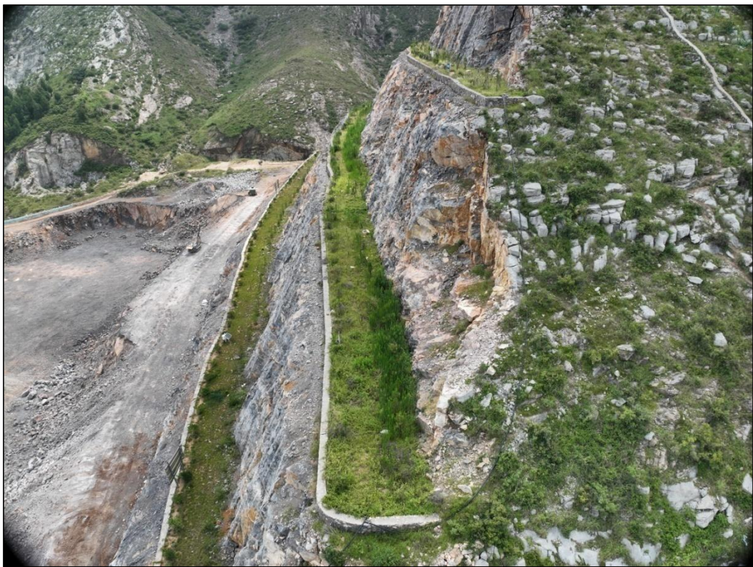
终了平台植物措施及浆砌石挡土埂
