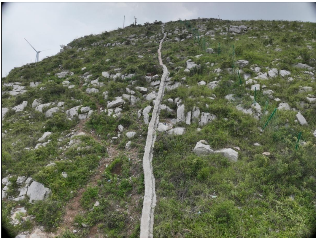
混凝土挡水埂
