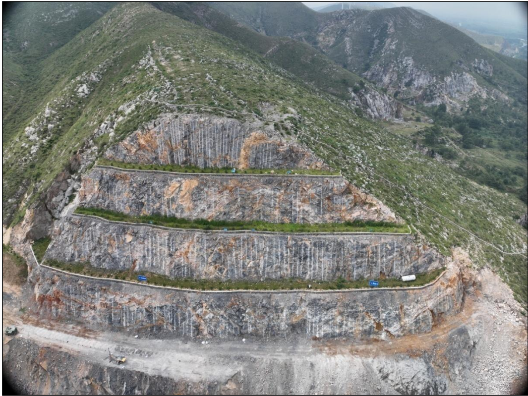
终了平台植物措施及浆砌石挡土埂
