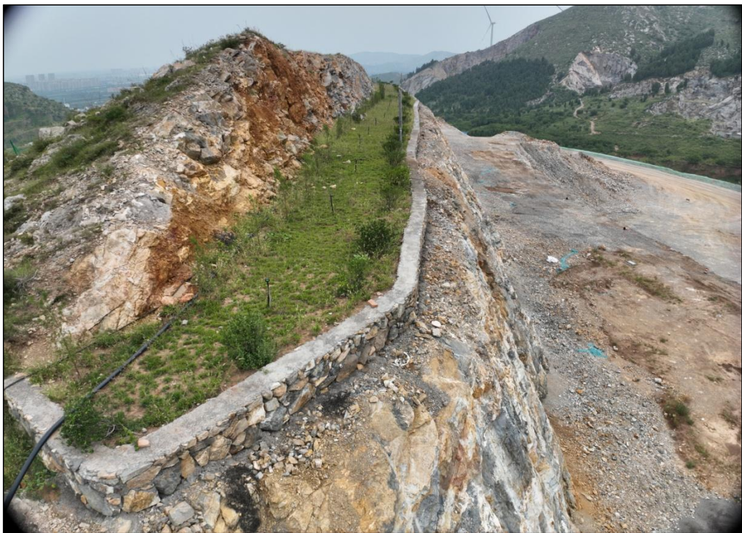
终了平台植物措施及浆砌石挡土埂
