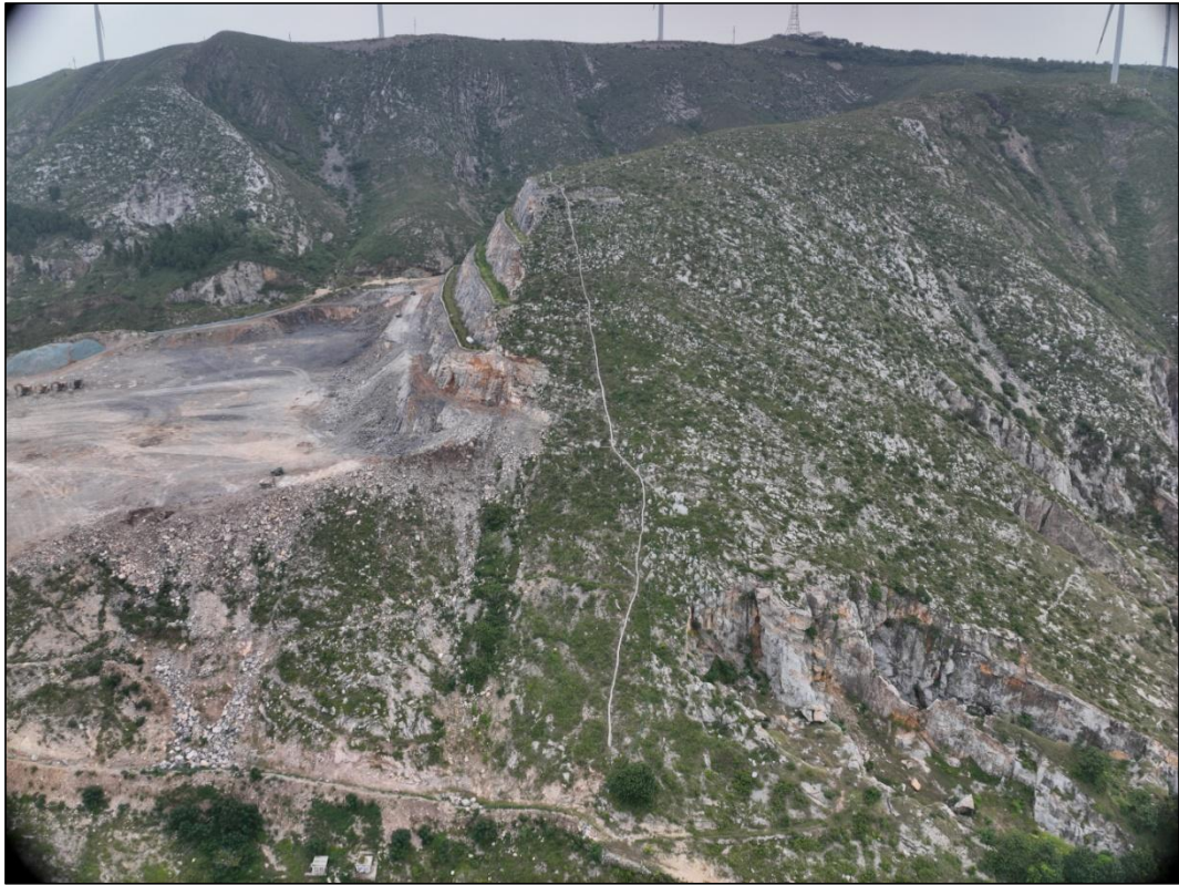
混凝土挡水埂
