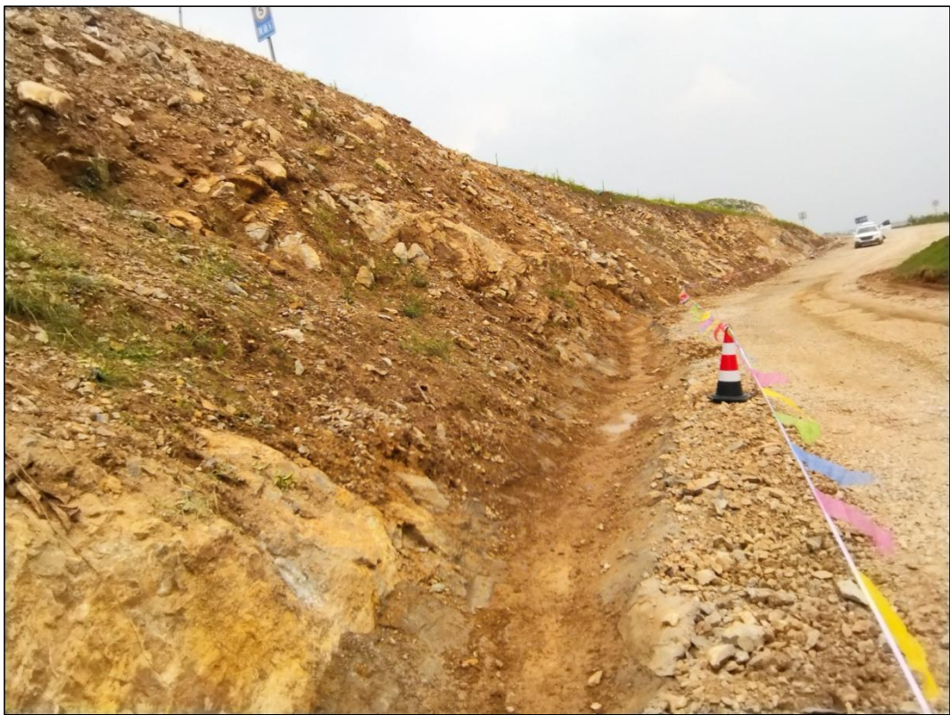
混凝土抹面排水沟
