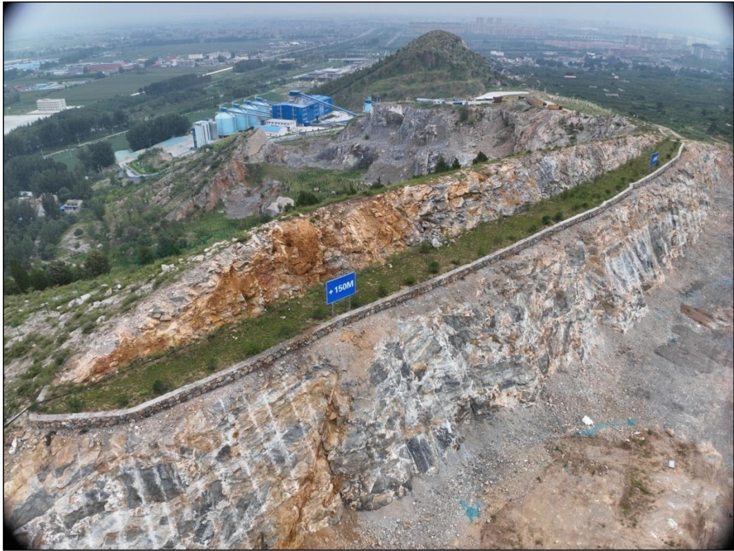
终了平台植物措施及浆砌石挡土埂
