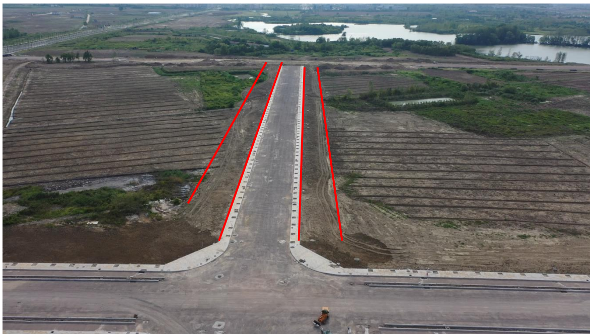
图 1.6 2022 年 8 月施工临时边坡
