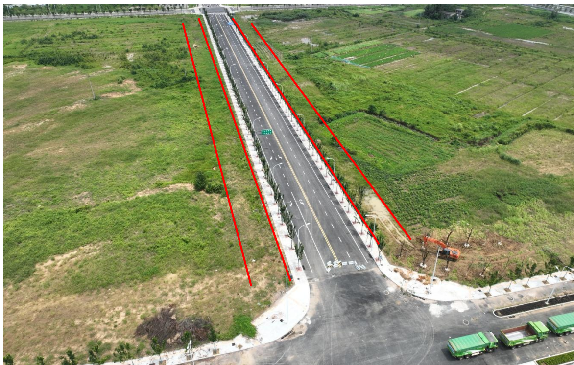
图 1.7 2023 年 7 月施工临时边坡现状
