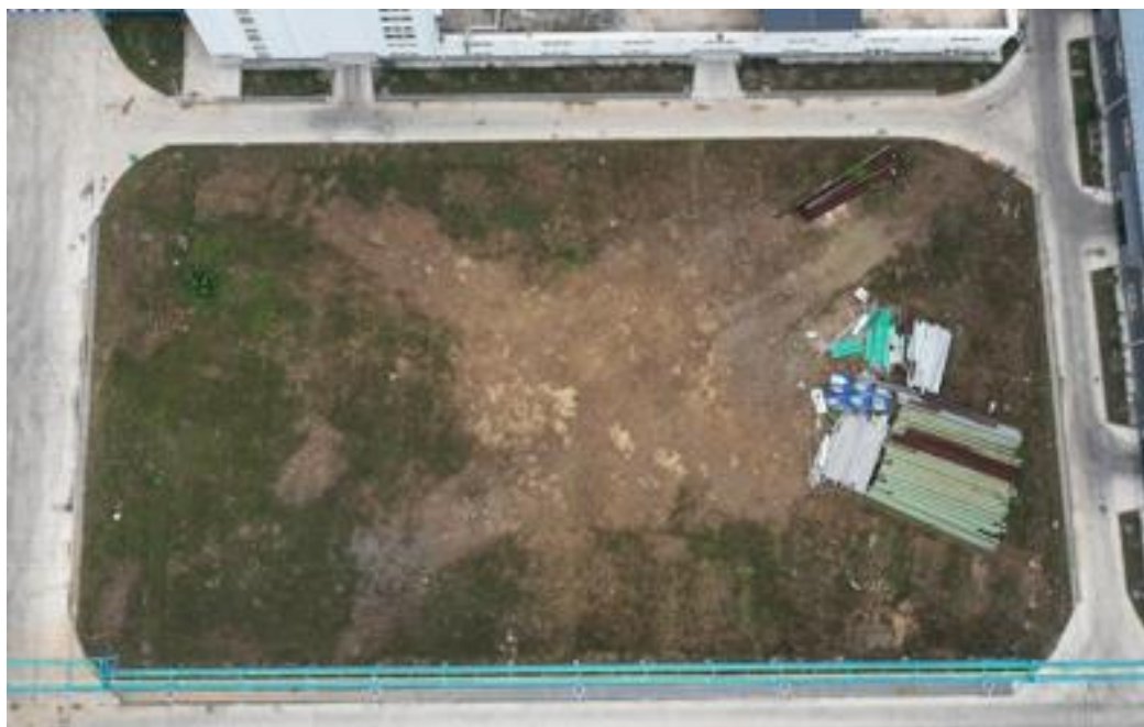
图 1.3 施工场地现状
