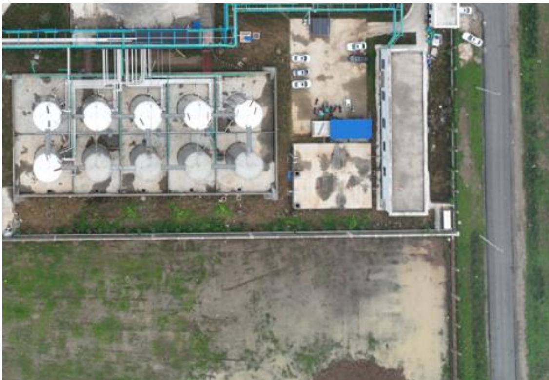
图 1.2 施工生活区现状
