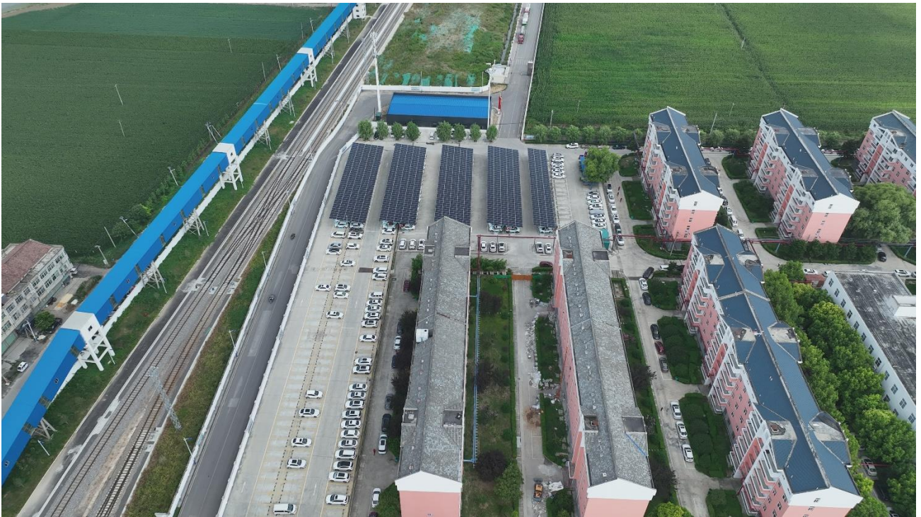
屋顶(停车场车棚)光伏区域现状
