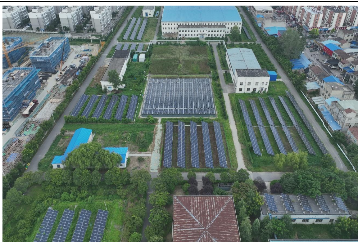
项目建设现状
