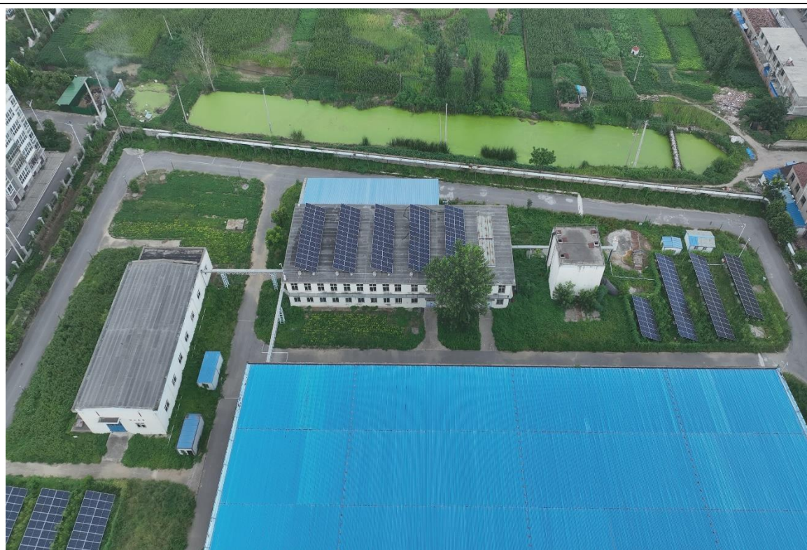
项目建设现状
