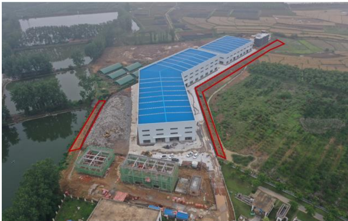
图 1.5 场外施工扰动区（边坡）
