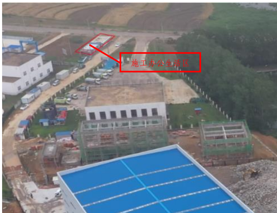
图 1.4 场外扰动区（施工办公生活区）
