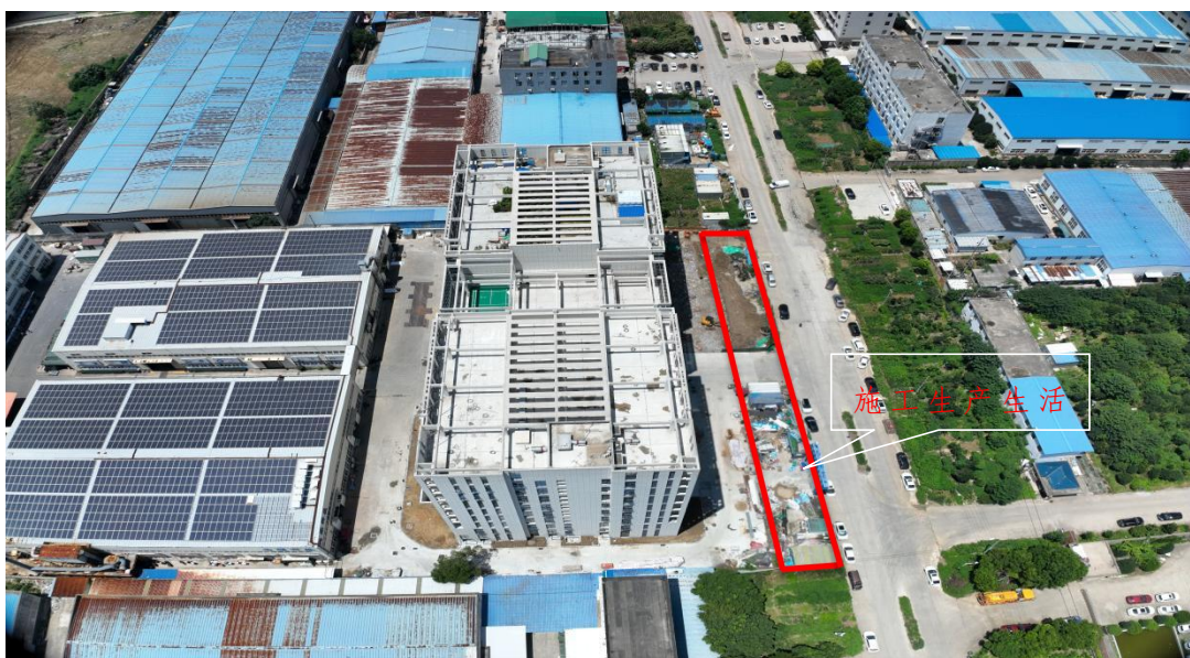
图 1.7 施工生产生活区现状
