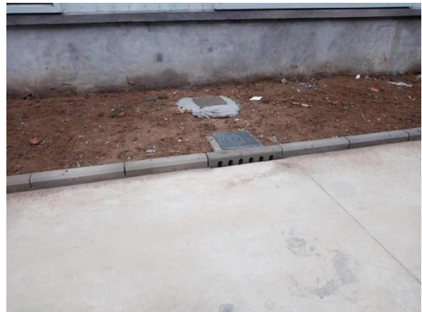
雨水井和雨水口布置
