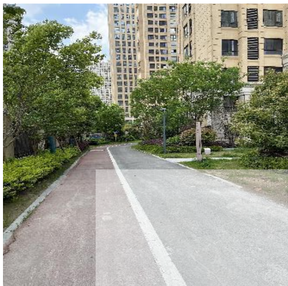
小区内部道路
