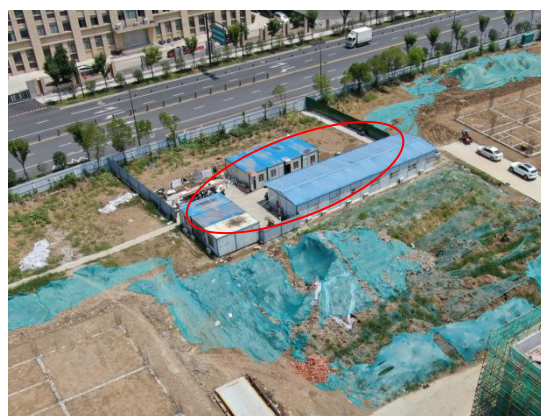
图 1.5 施工场地现状图
