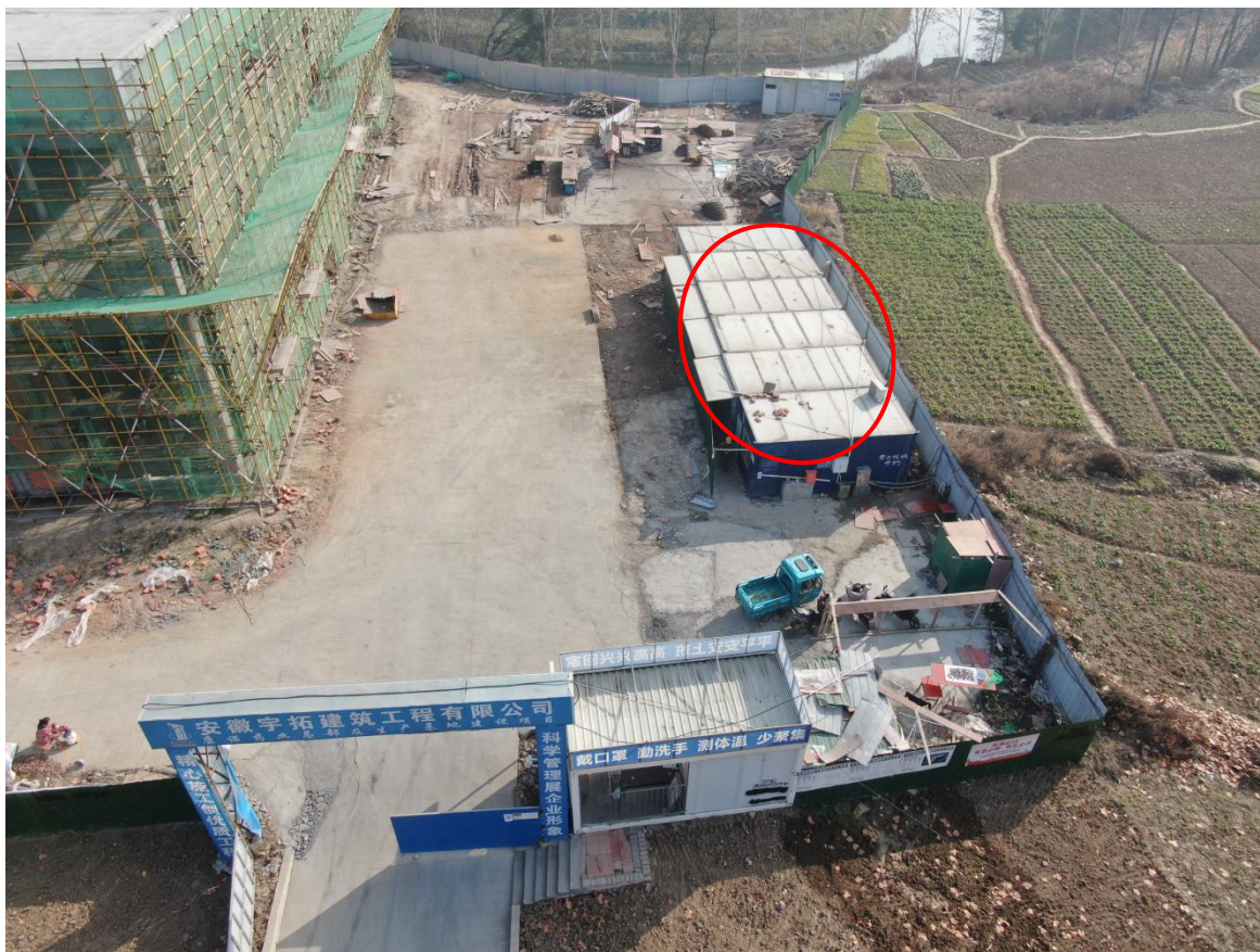
图 1.3 施工场地现状图
