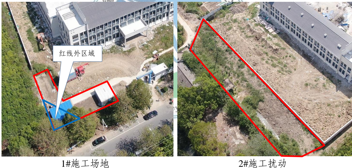
图 1.4 施工场地现状图
